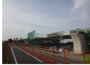
PD15-16支保工組立中
