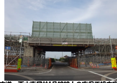
市道 西山南居林1号線線上の支保工組立完了
