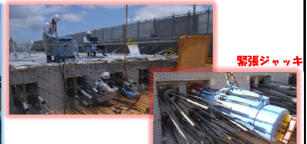
PC鋼材 緊張作業状況
