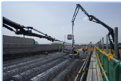
コンクリート打設状況
