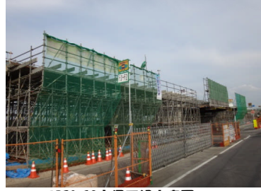
PD20-19支保工組立完了
