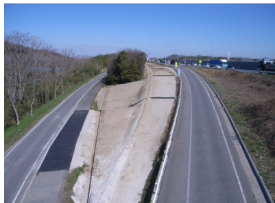
ランプ盛土完成(起点より終点を望む)
