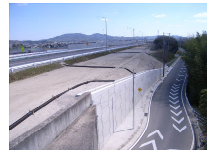
ランプ盛土・擁壁完成(終点より起点を望む)
