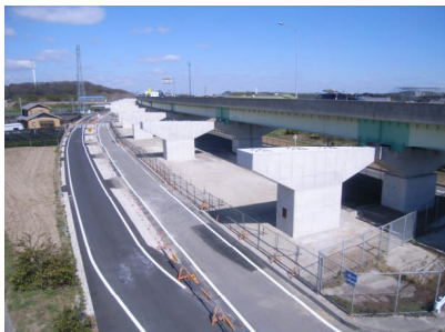
橋脚完成(起点より終点を望む)
