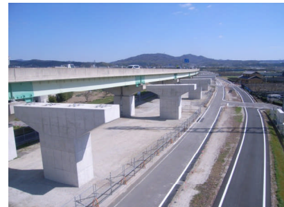
橋脚完成(終点より起点を望む)
