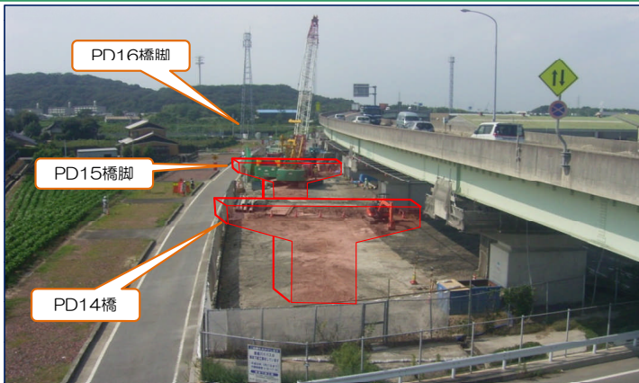
8月31日現在 PD16 基礎杭施工中
