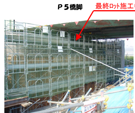
PD5橋脚 最終ロフト施工中
