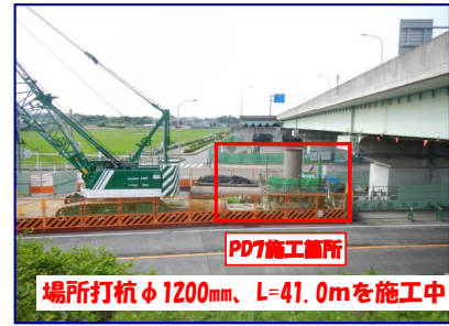
施工中 (PD7とPD8橋脚)
