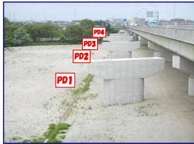
施工完了 (PD1からPD6橋脚)
