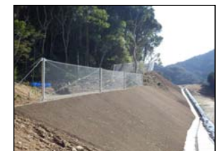
落石防護柵工
