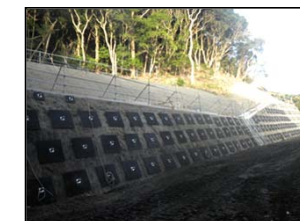
法面工(切土補強)
