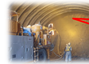
コンクリート吹付
