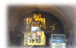
ロックボルト打込み
