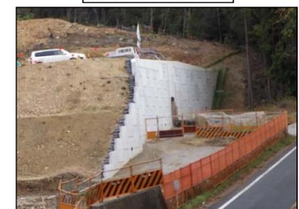
※切土補強は、切土した法面が崩れないように法面に鉄筋を挿入することで、法面の補強をおこなう工法です。
