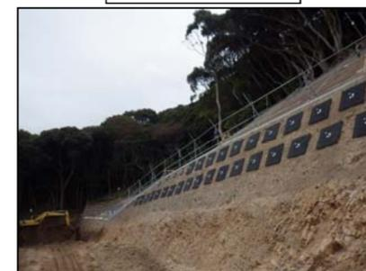
擁壁工(補強土壁)
