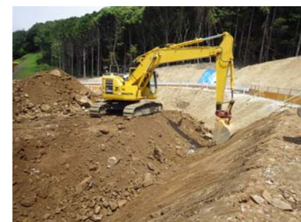
土砂掘削状況
