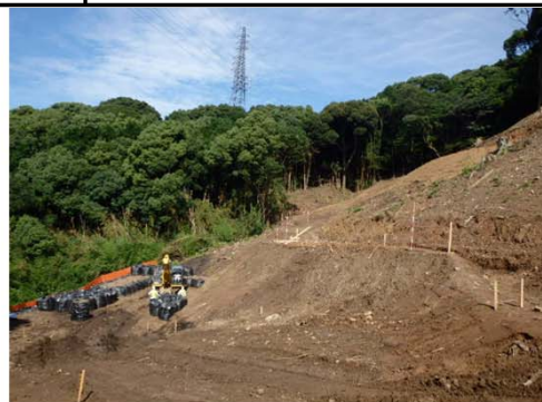
豊橋側より名古屋側を望む
