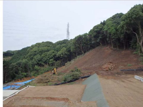
豊橋側より名古屋側を望む
