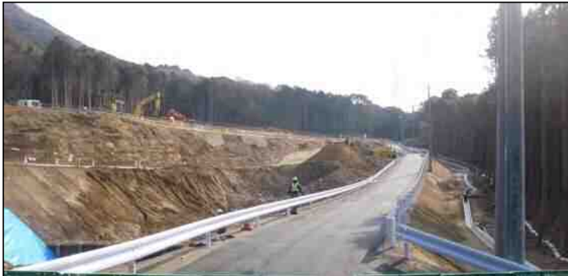
名古屋側より豊橋側を望む(施工中)
