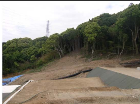
豊橋側より名古屋側を望む
