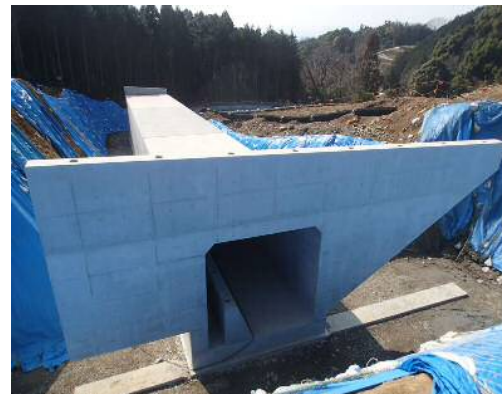
5号排水路完成
