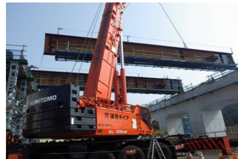
鋼桁架設状況
