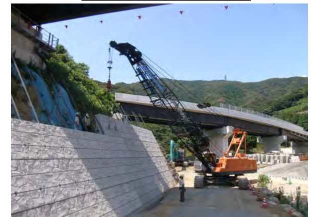
大型ブロック施工状況
