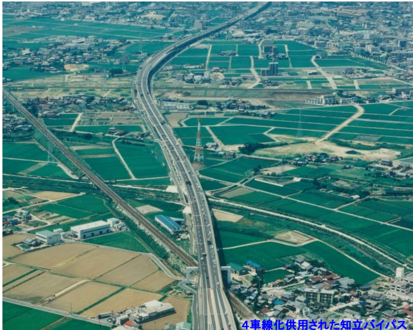
4車線化供用された知立バイパス
