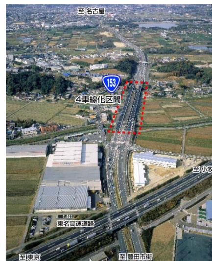
豊田西バイパス 最後の4車化区
