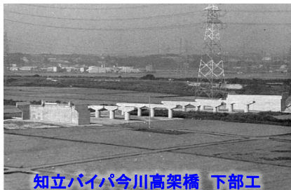
知立バイパス今川高架橋 下部工
