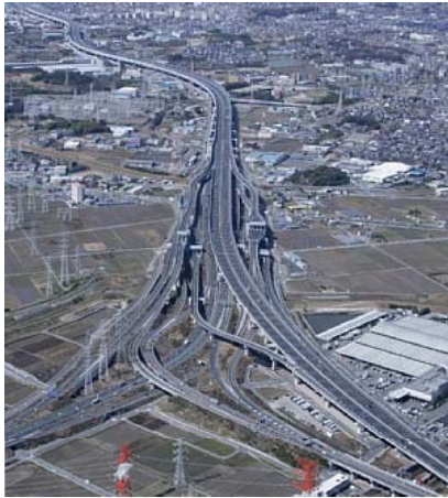
立体化された栄交差点付近
