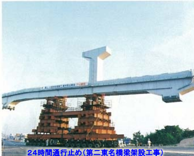
24時間通行止め(第二東名橋梁架設工事)
