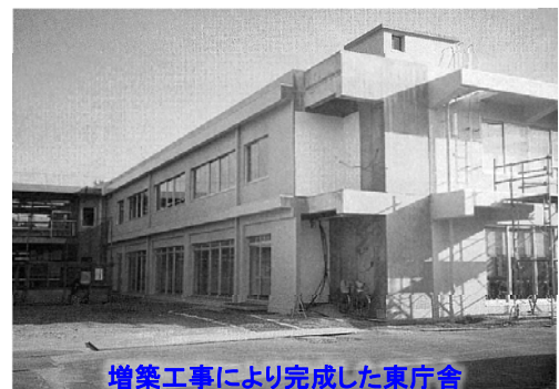
増築工事により完成した東庁舎
