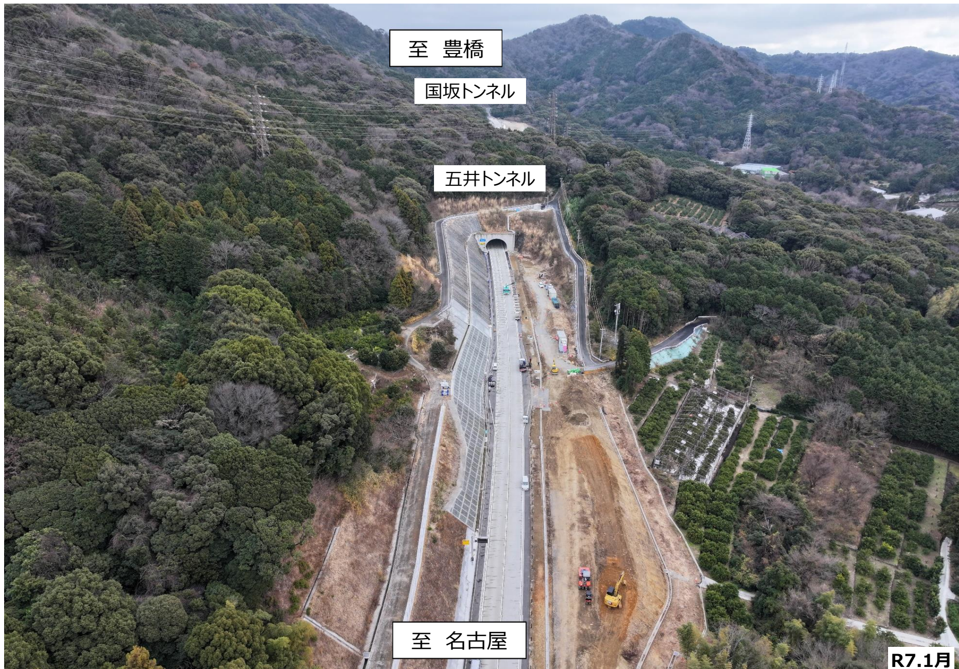
五井トンネルから豊橋方面を望む
