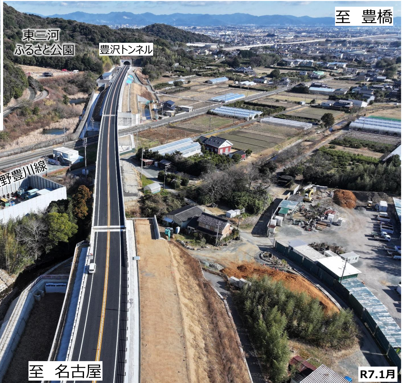
金野豊川線付近から豊沢トンネルを望む
