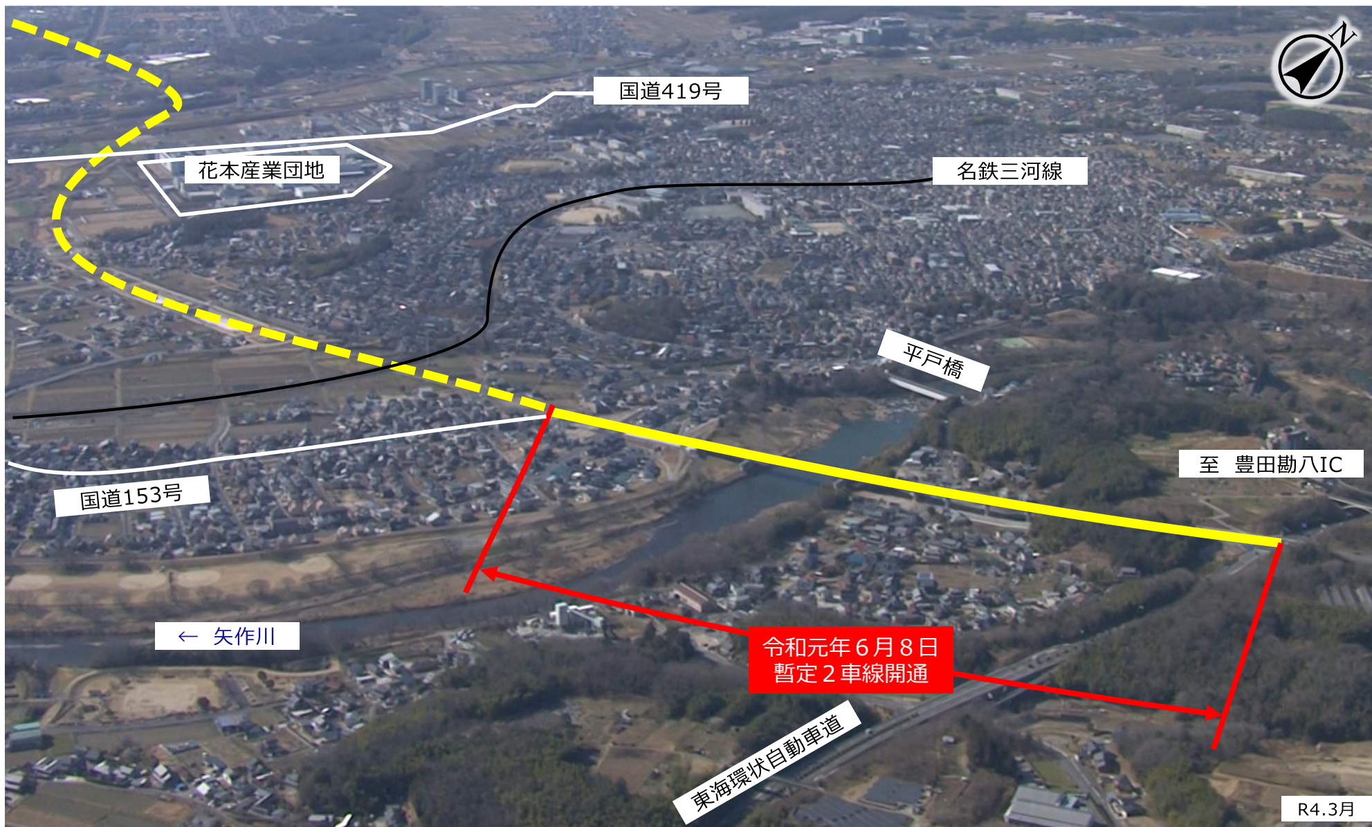
豊田勘八IC付近から豊田市上原町方面を望む
