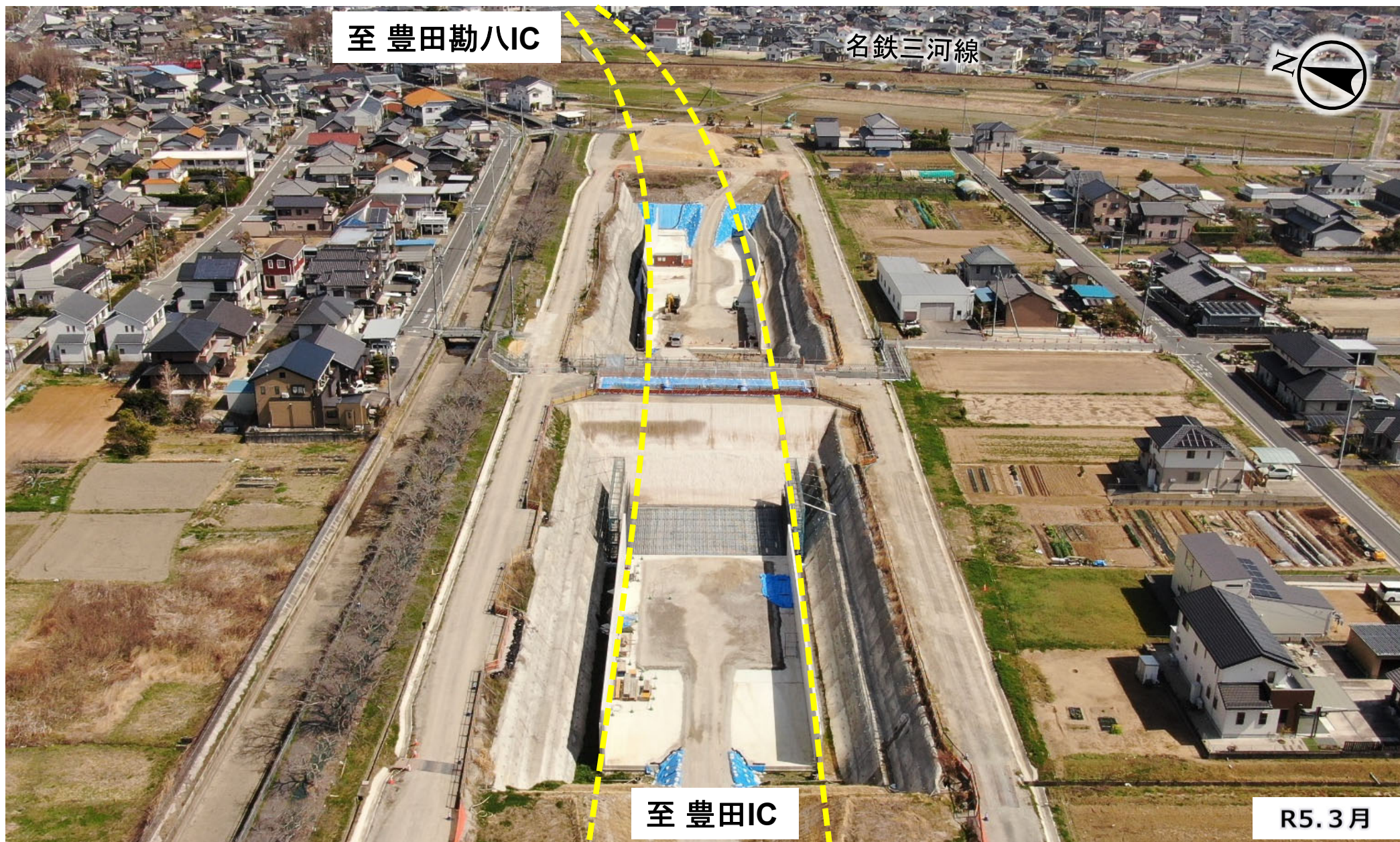
豊田市花本町付近から豊田勘八IC方面を望む
