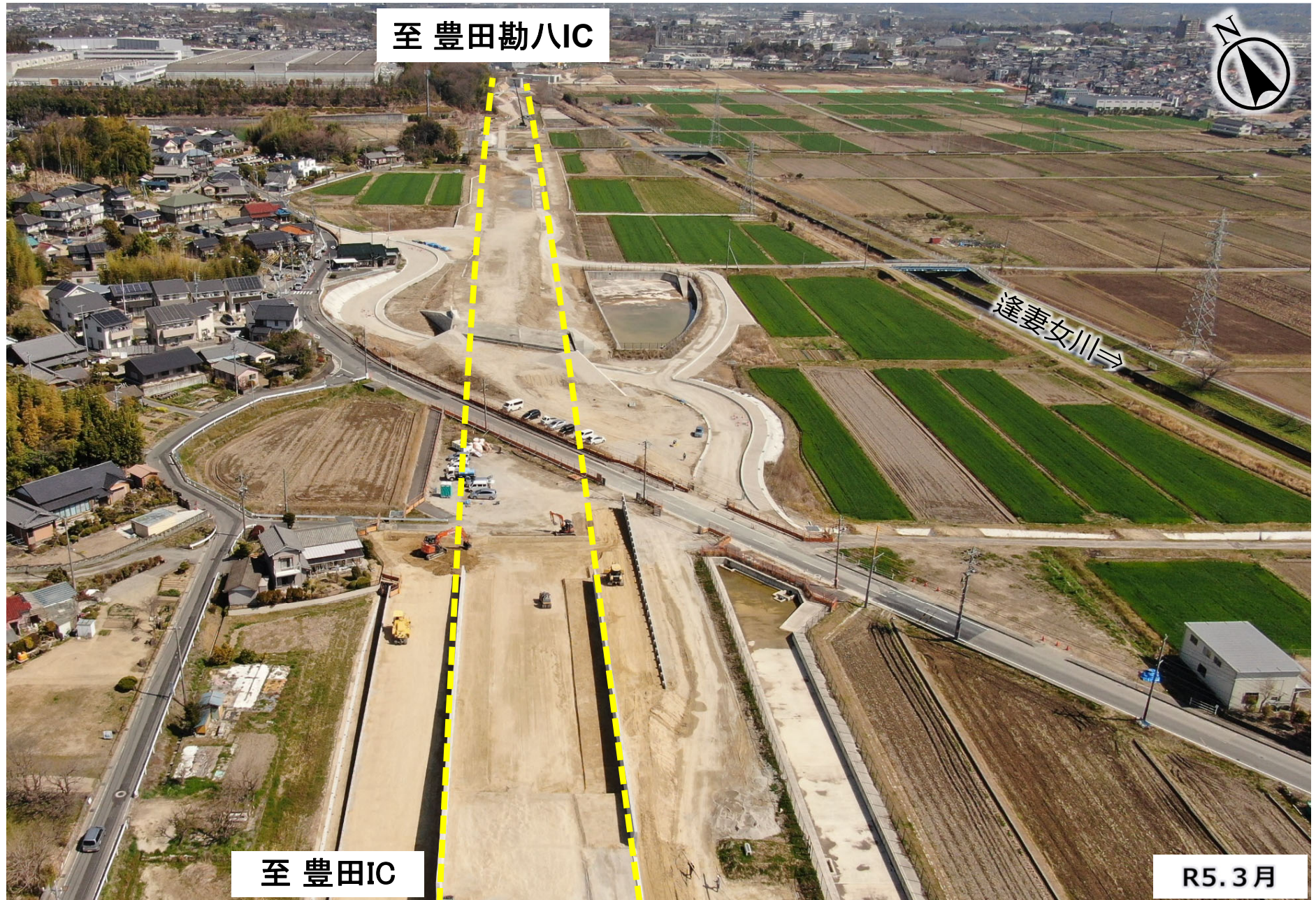
豊田市天王町付近から豊田勘八IC方面を望む
