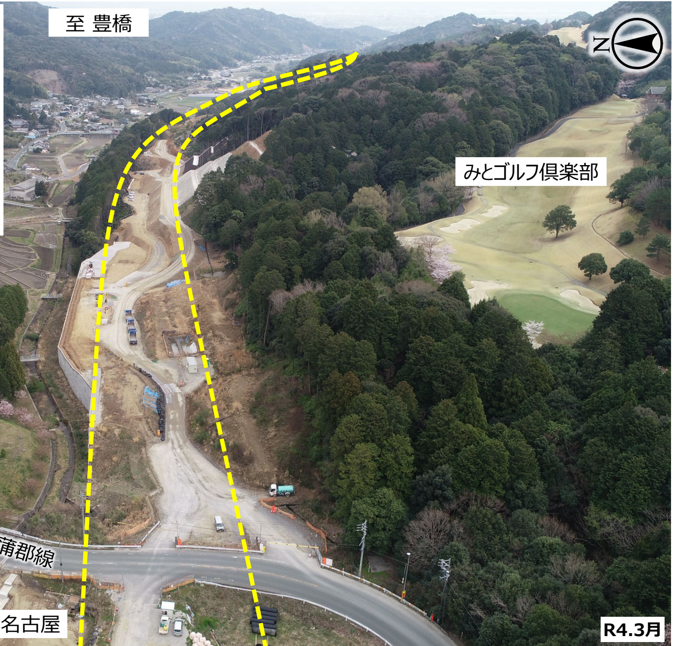
国坂トンネルから豊川市御津町方面を望む
