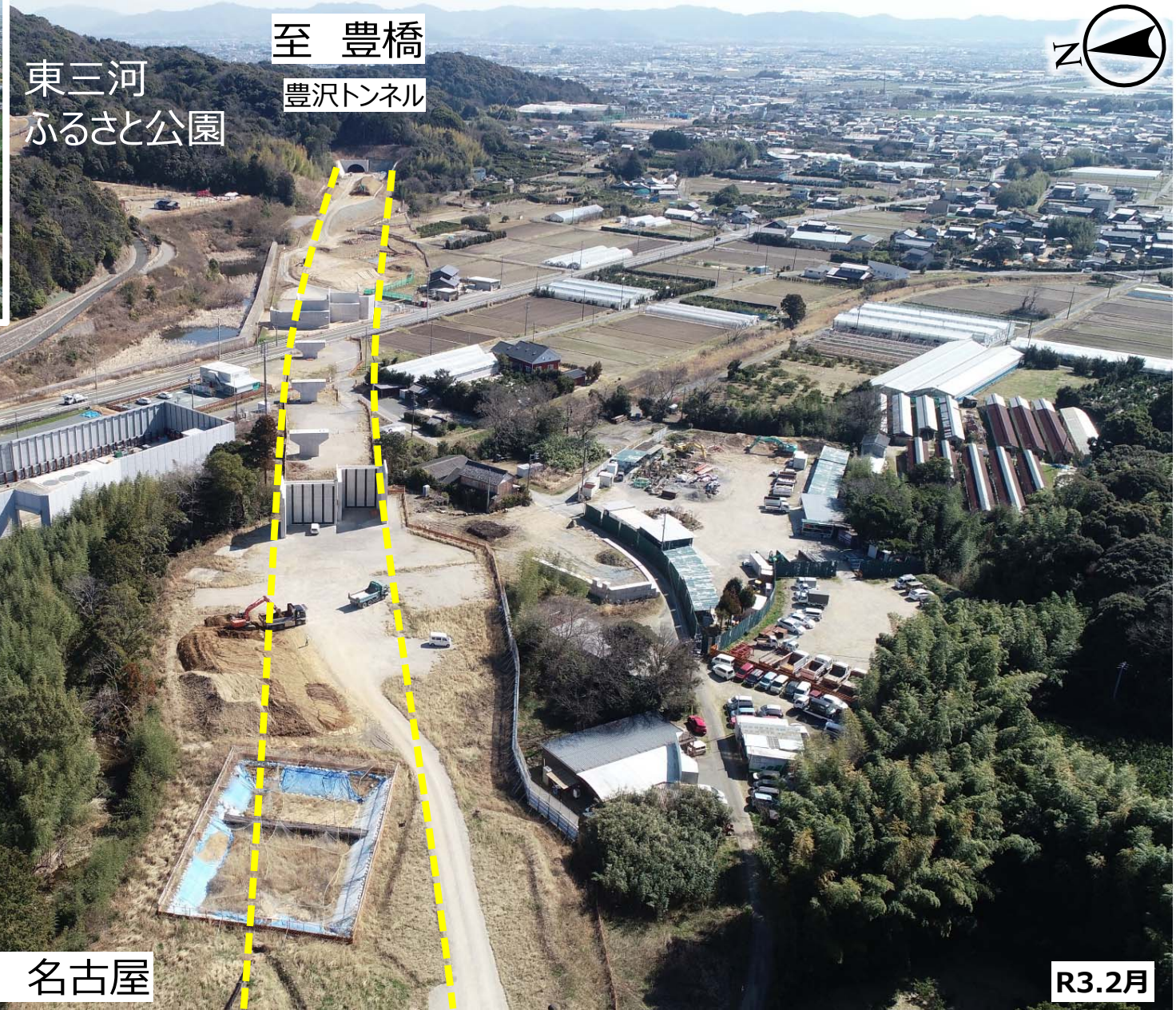
豊川市御津町から豊沢トンネルを望む
