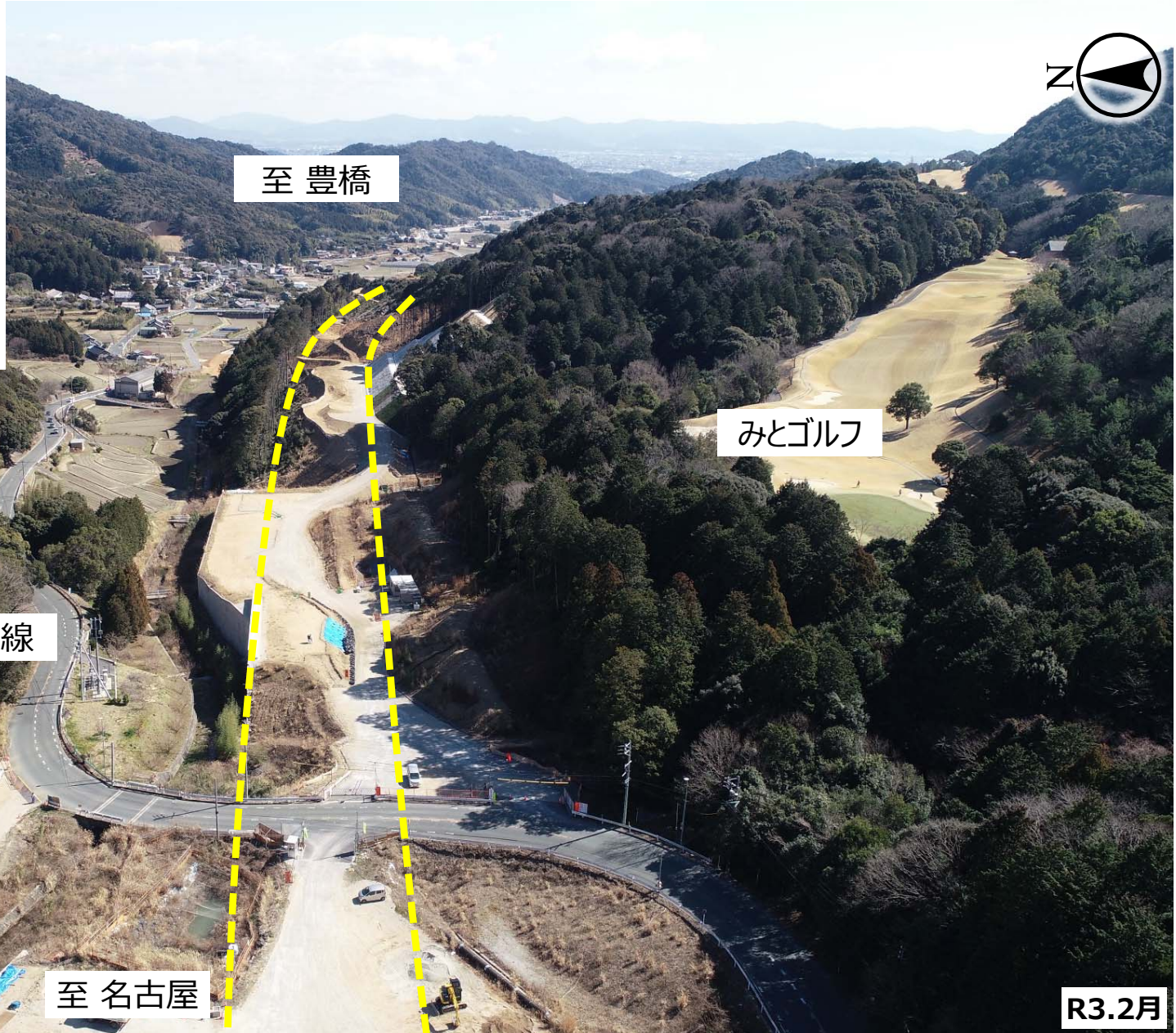
国坂トンネルから豊川市御津町方面を望む
