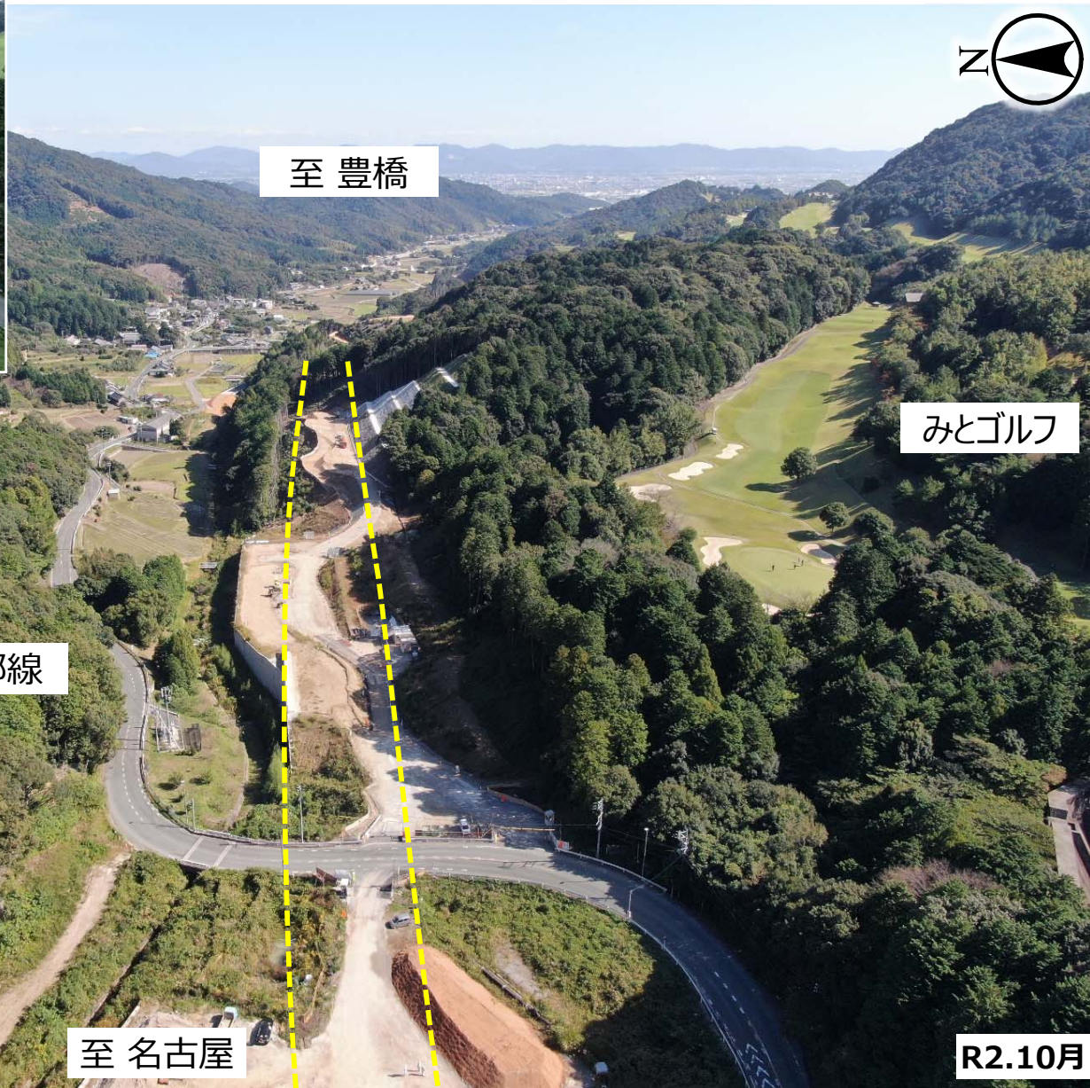
国坂トンネルから豊川市御津町方面を望む
