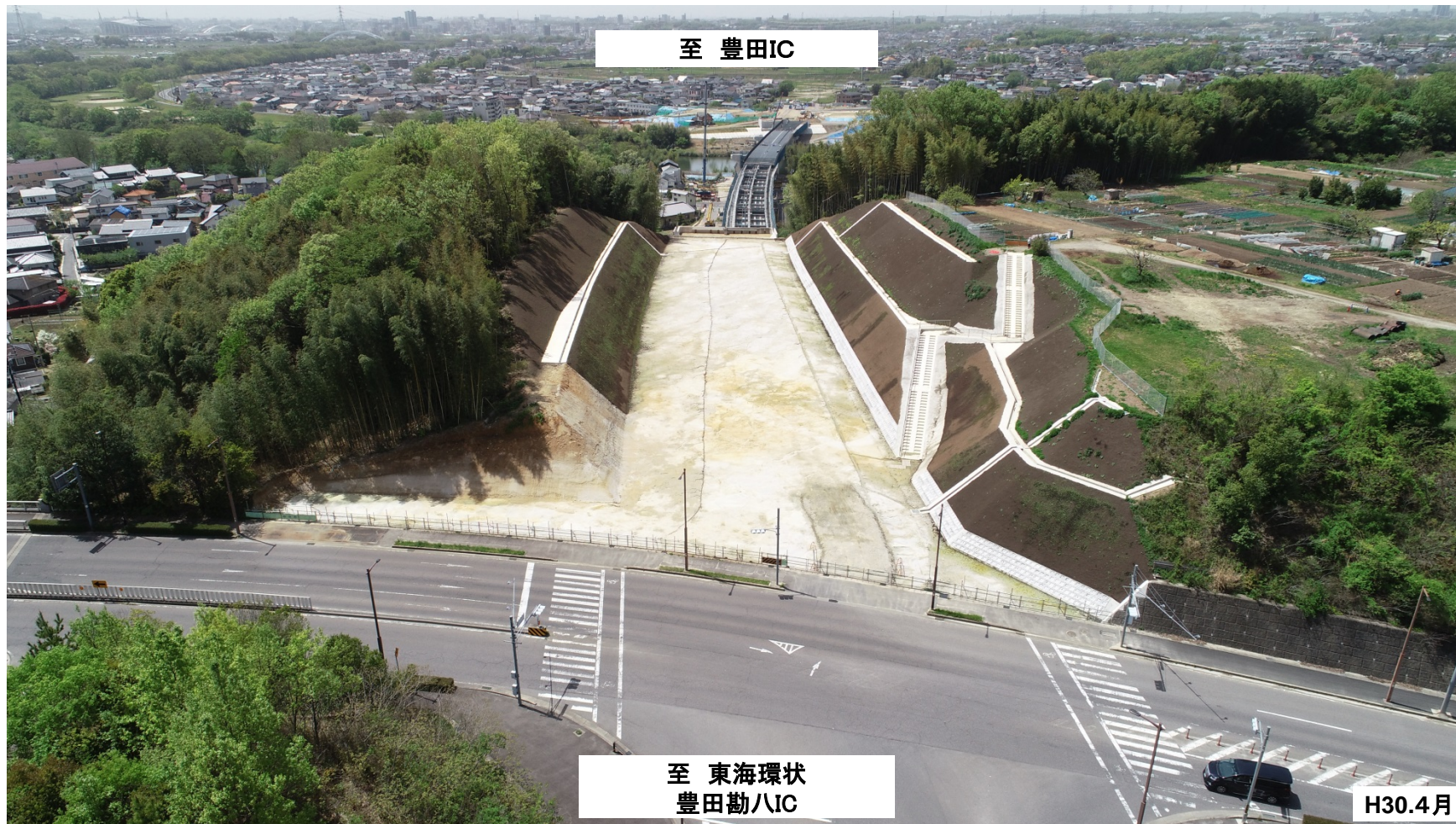
矢作川左岸側 整備状況
