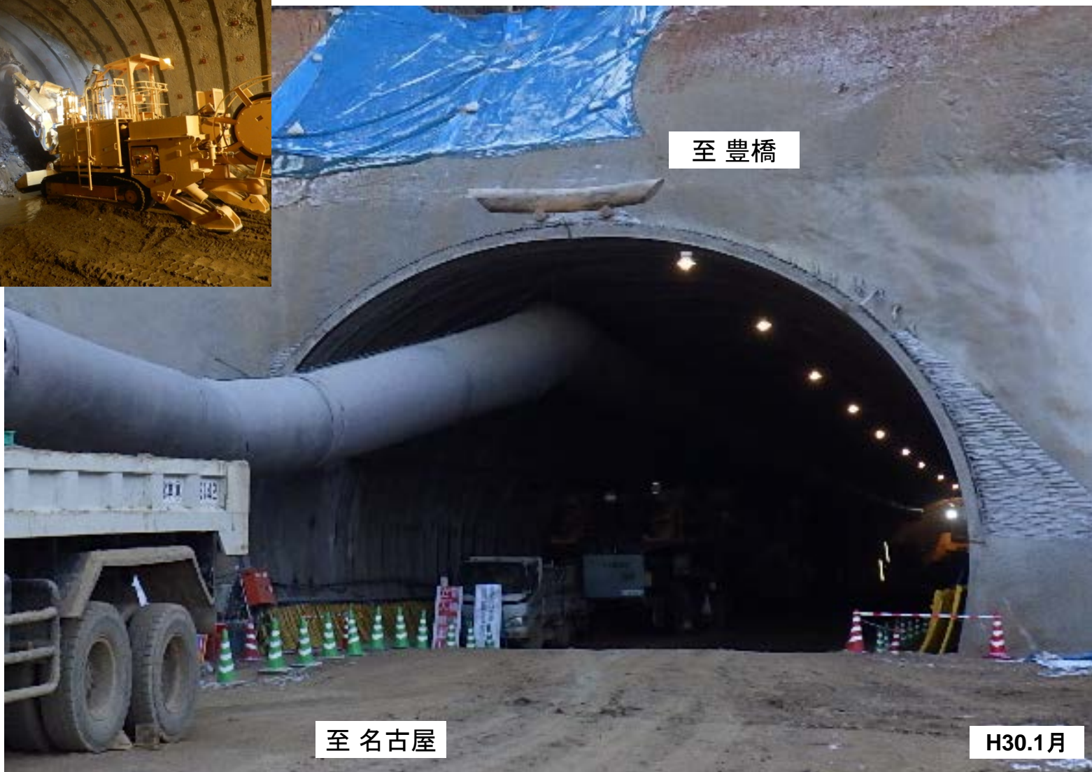
豊沢トンネルの名古屋側坑口(延長536m)施工状況
