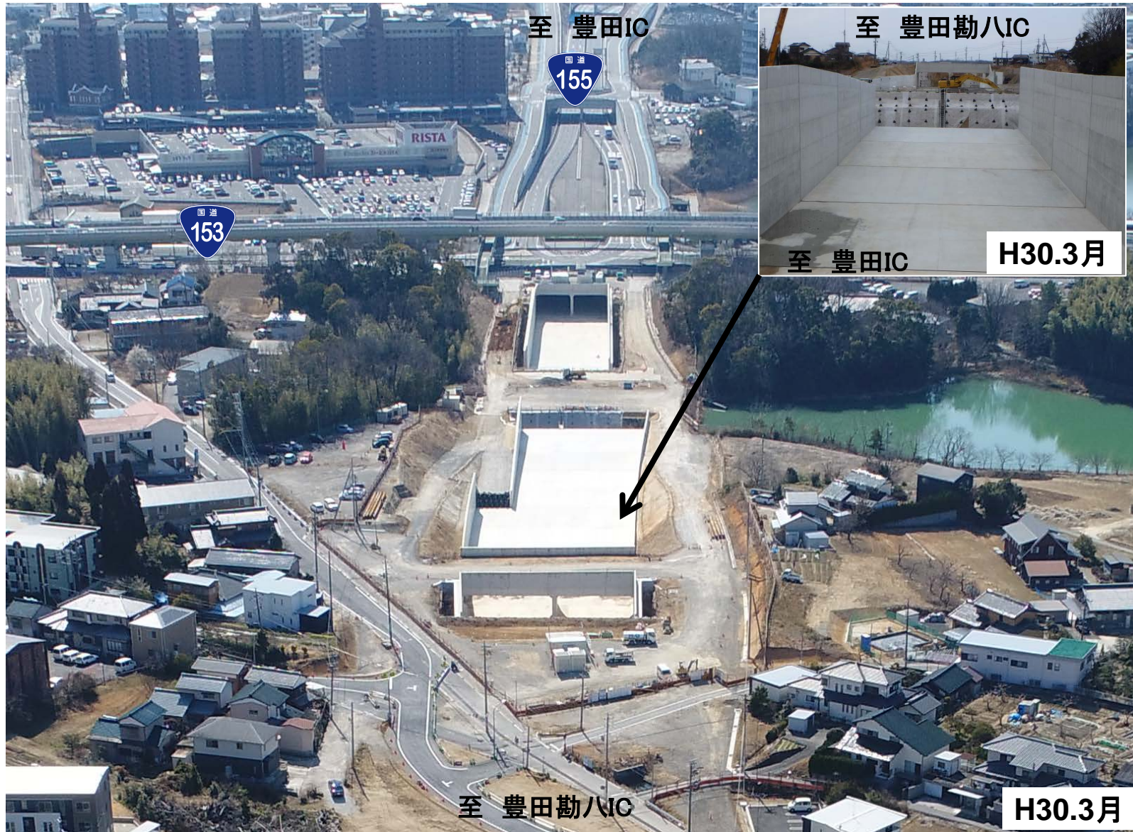
豊田市東新町付近から豊田勘八IC方面を望む
