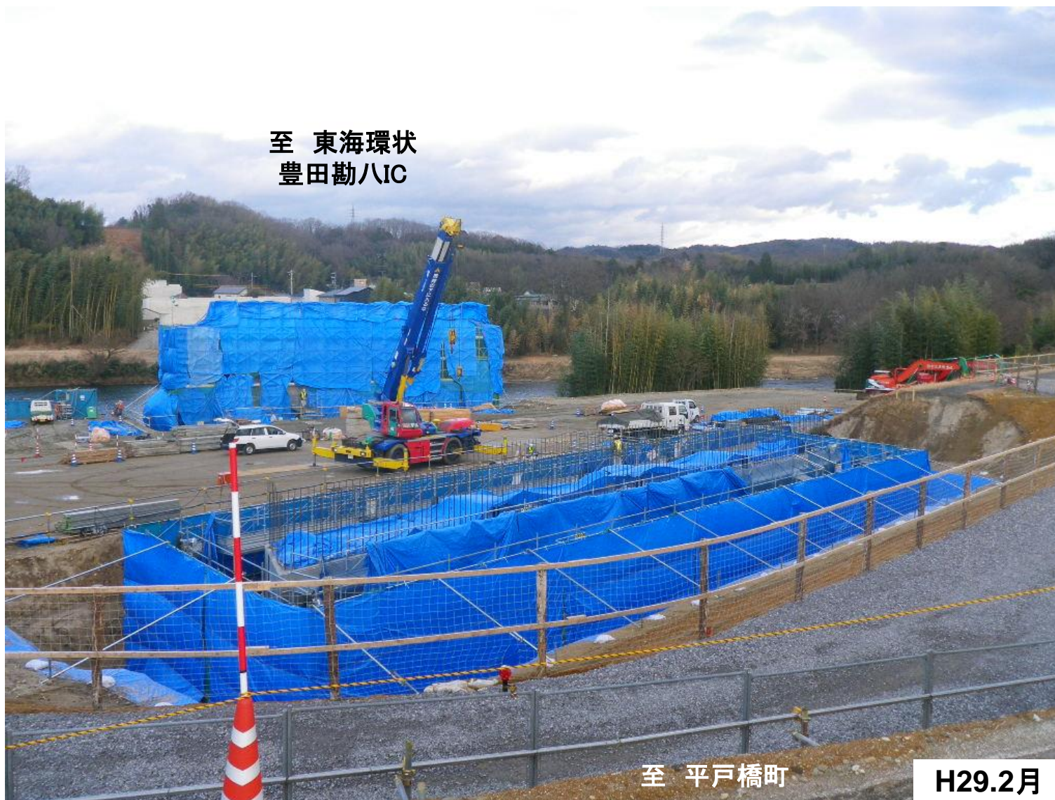
矢作川右岸側 整備状況
