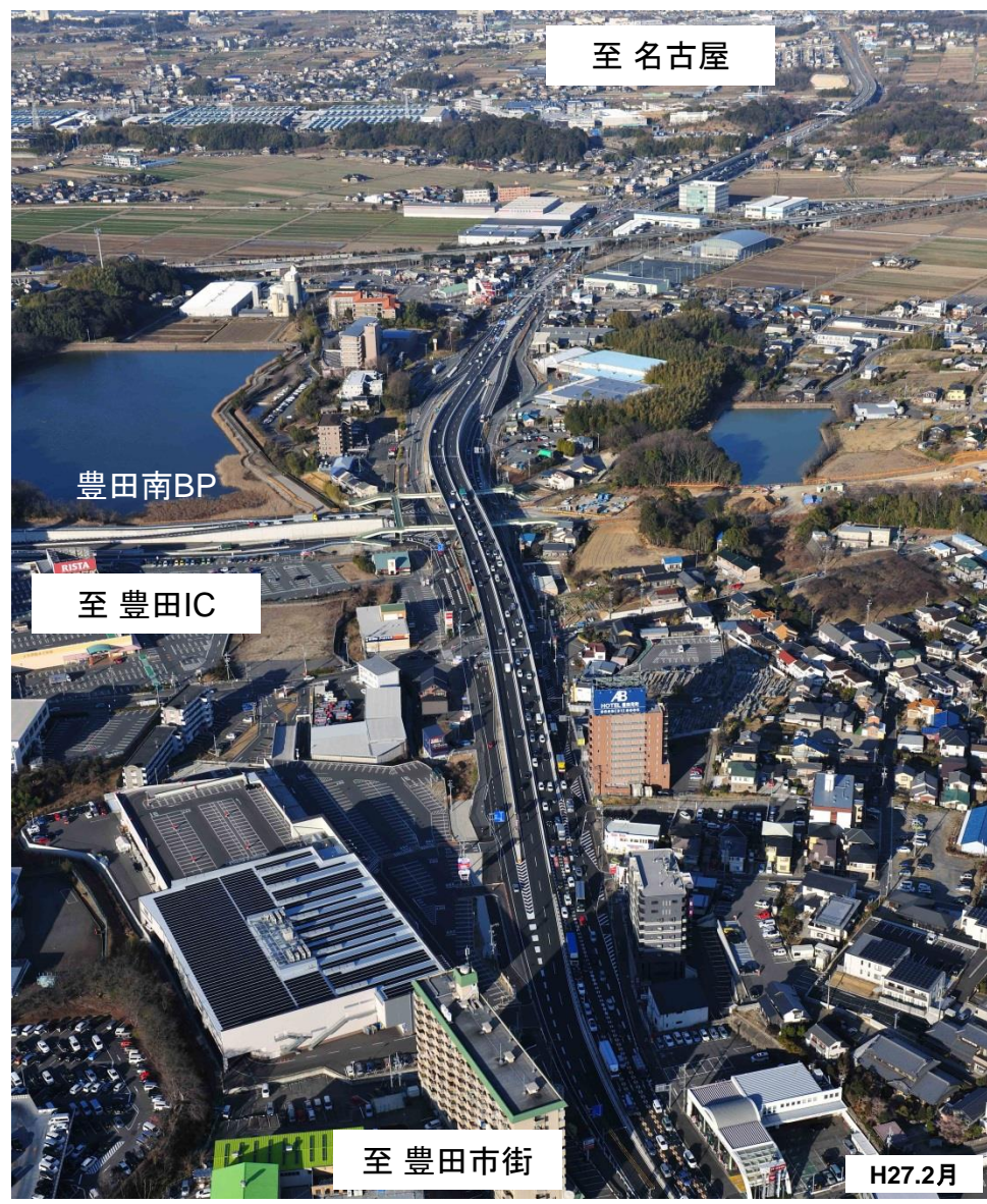
東新高架橋を望む
