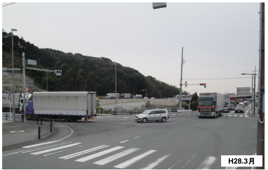
蒲郡IC付近上大内東交差点 大型車が多く利用
