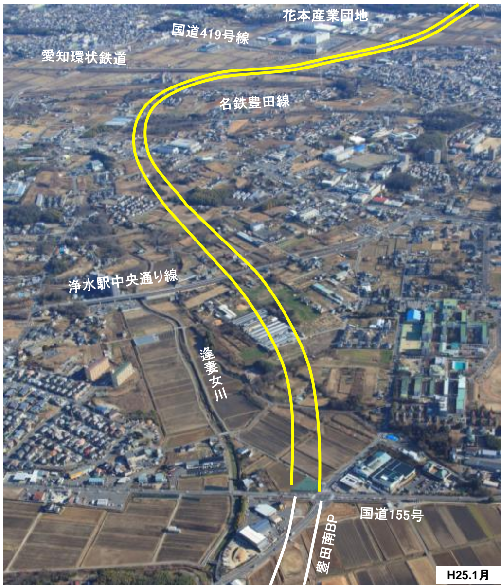
豊田市逢妻町付近から豊田市上原町方面を望む
