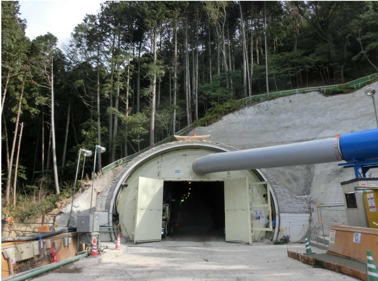
国坂トンネルの名古屋側抗口(延長678m)施工状況(約374m掘削 4月末現在)
