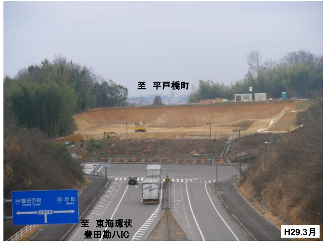
矢作川左岸側 整備状況
