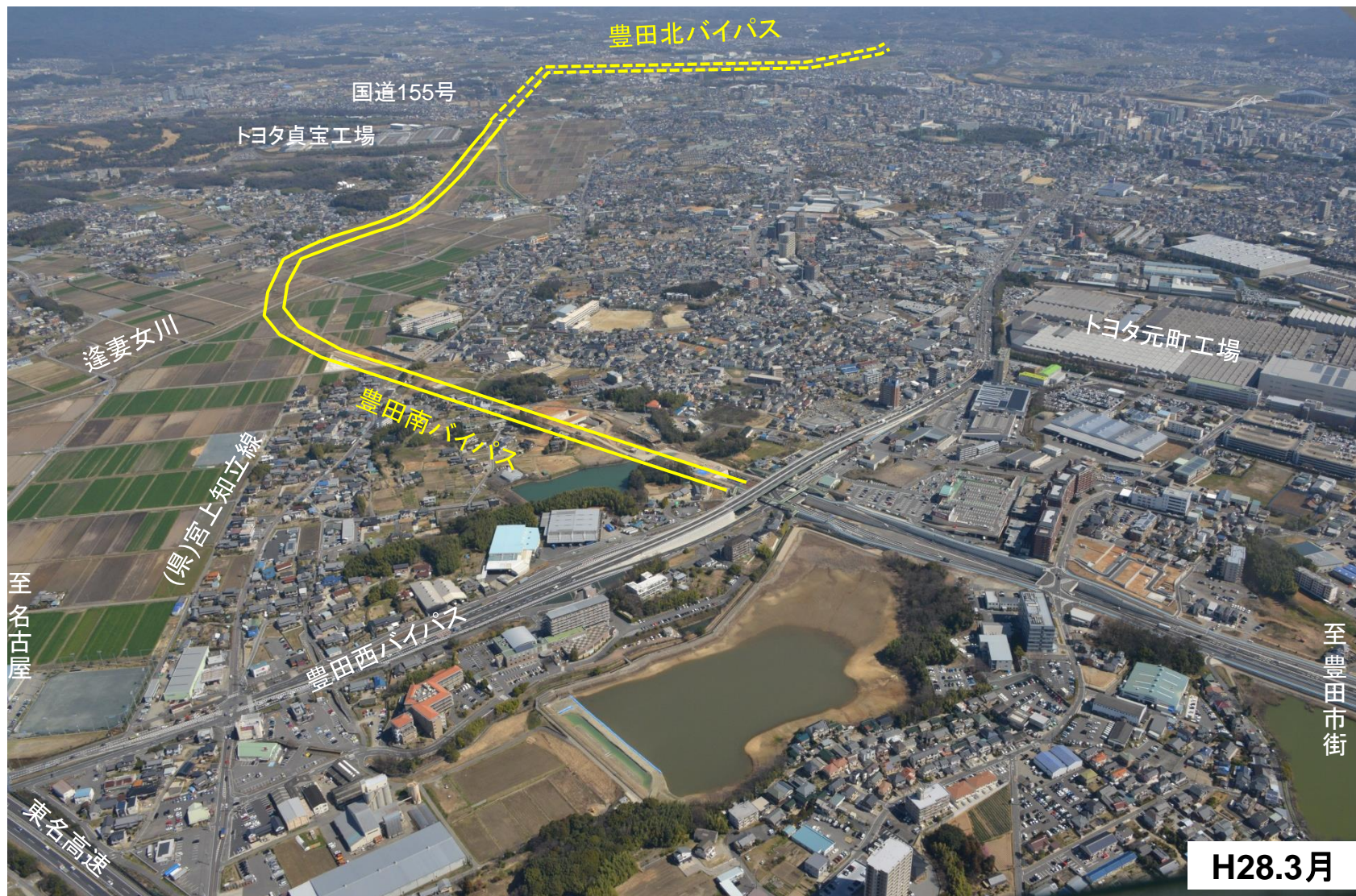
豊田市東新町付近から豊田勘八IC方面を望む
