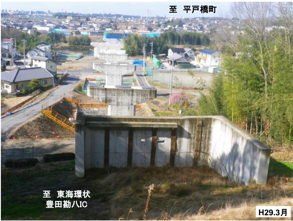
矢作川左岸側 整備状況
