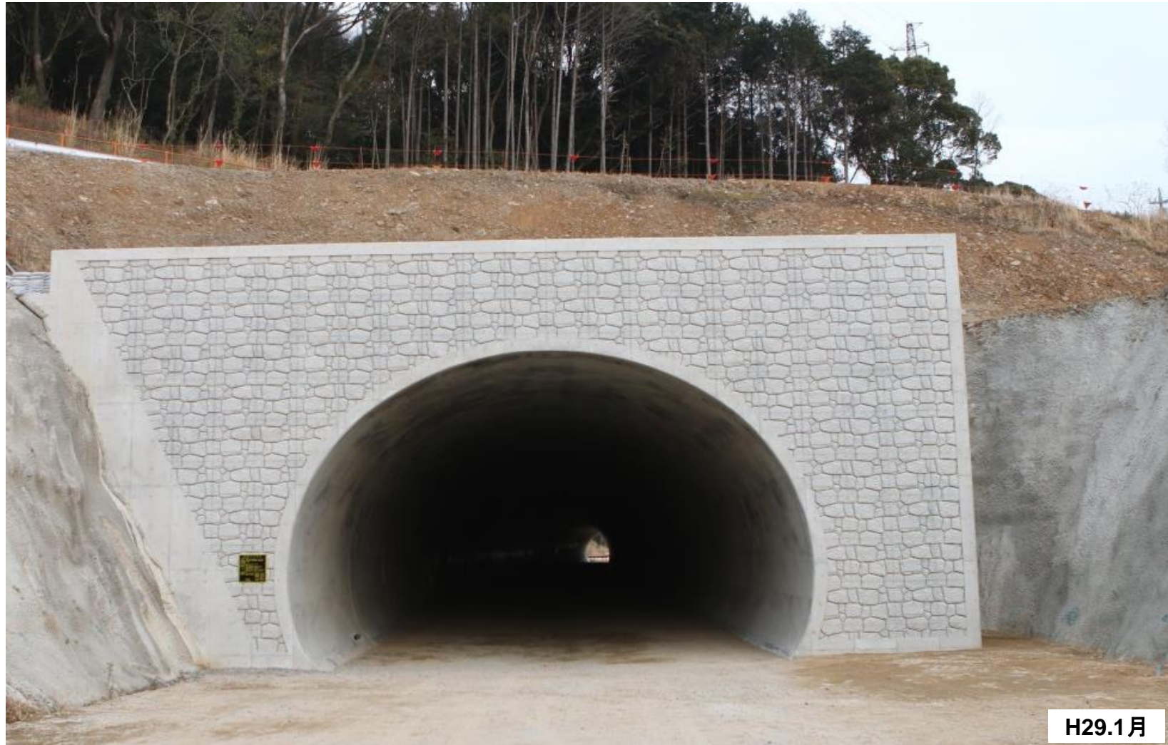
五井トンネル(名古屋側抗口)の状況(延長299m)H28.8月貫通
