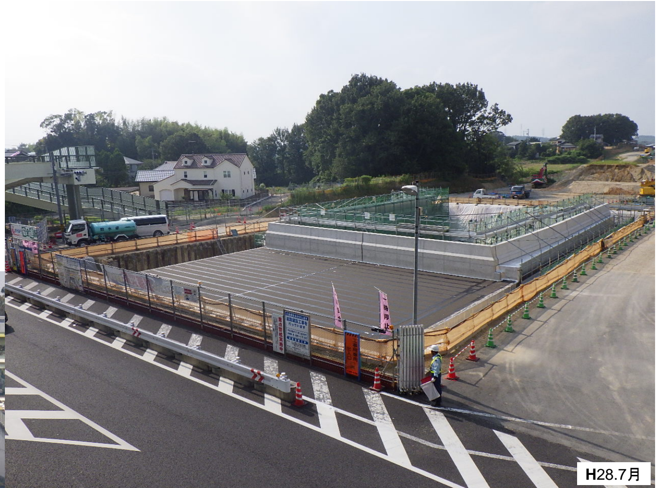
東新町地区の施工状況
