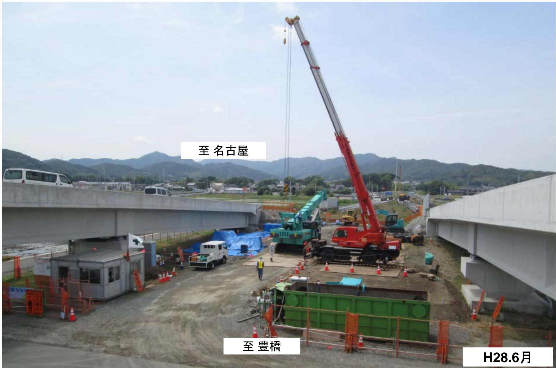
豊川為当ICの施工状況(橋梁下部工事)
