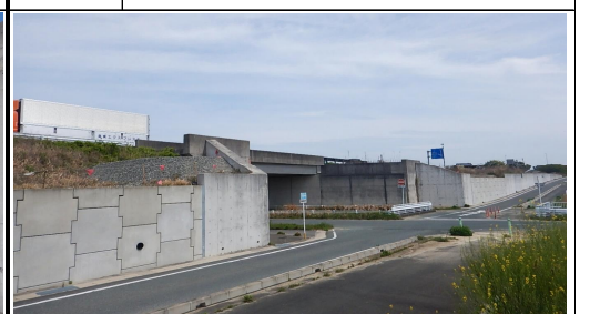
名古屋側より浜松側を望む
