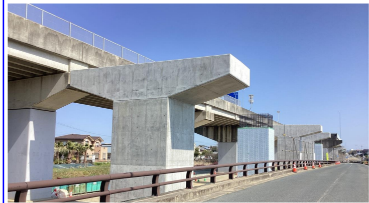
名古屋側より浜松側を望む
