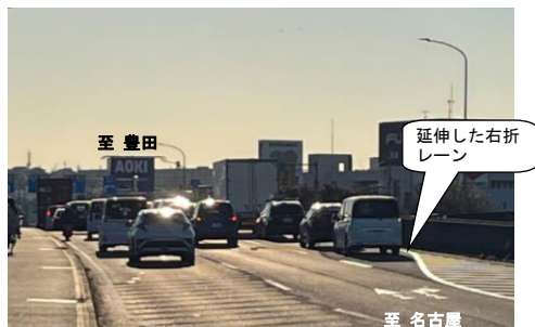
①西側流入部（国道153号）右折レーン延伸
