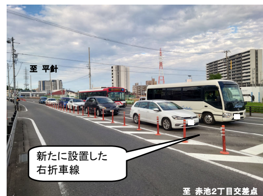
②南西側流入部（市道小田赤池線）右折2車線化
