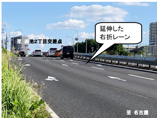
①北西側流入部（国道153号）右折レーン延伸
