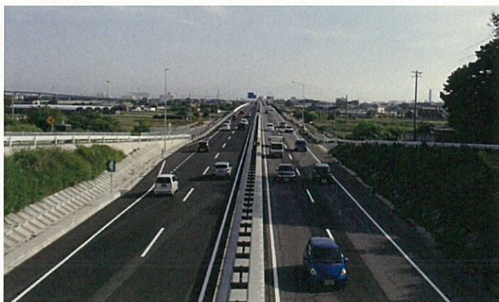
○大崎IC~豊橋港IC間 4車線化完了状況
