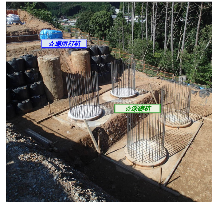
杭施工完了全景(Bランプ)
