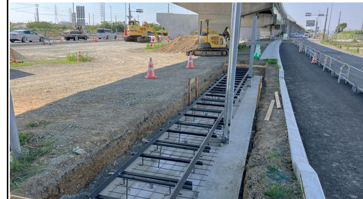
浜松側より名古屋側を望む
