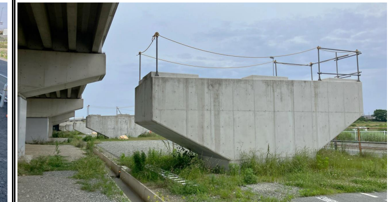
名古屋側より浜松側を望む
