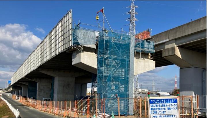
豊橋側より名古屋側を望む
