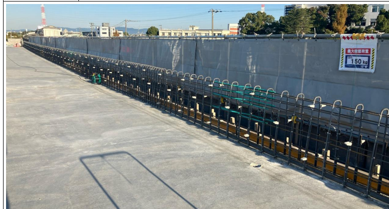
豊橋側より名古屋側を望む
