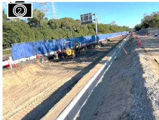
延伸OFFランプ部 掘削作業中
