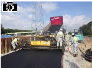
アスファルト舗装状況
