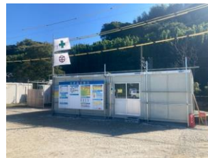
現場休憩所設置
