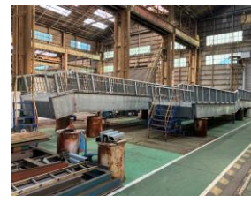
工場製作状況(階段形製作中)
