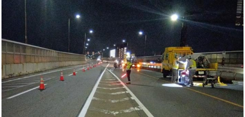
緊急夜間工事
