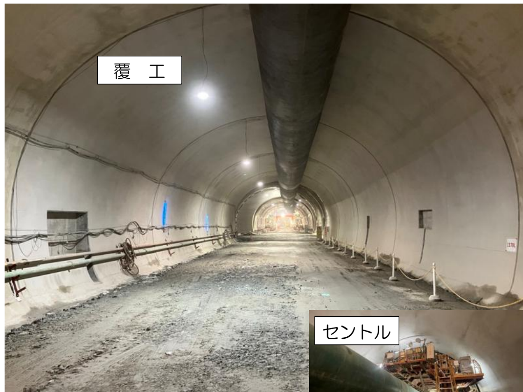
覆工全景写真
