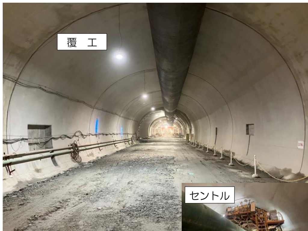
覆工全景写真
