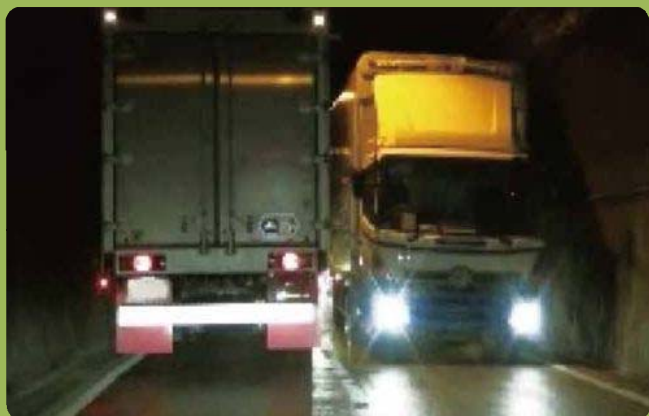
大型車のすれ違い困難が解消
