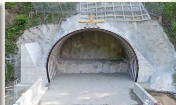
トンネル終点側坑口
