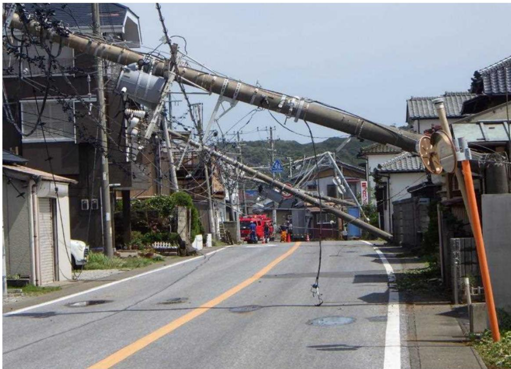
令和元年台風15号による電柱倒壊 (千葉県館山市)
