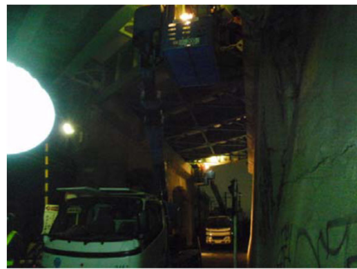
点検状況(高所作業車)
