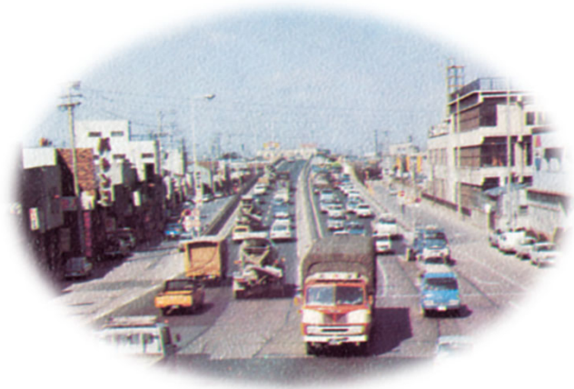
▲1968年（昭和44年）【昭和43年に4車線供用】 熱田伝馬橋拡幅工事完成時の写真 （内浜交差点から熱田伝馬橋を望む）
