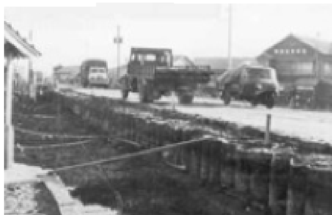
ドラム缶工法で復旧した道路
