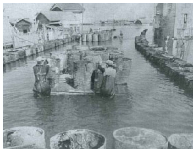
国道1号蟹江～弥富の 「ドラム缶工法」現場
