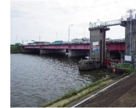
日光川大橋 (1961年架設)
