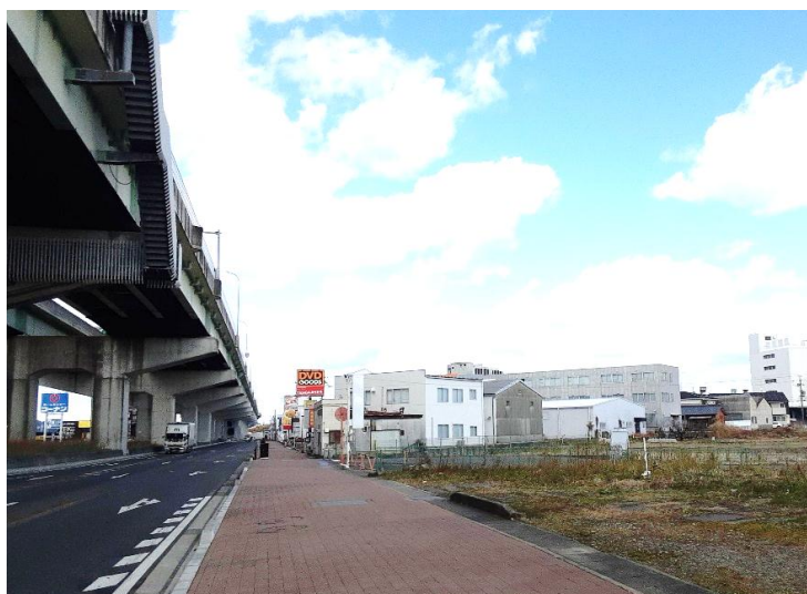
電線共同溝整備後
