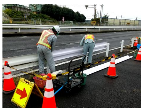
応急対応(付属物補修)
