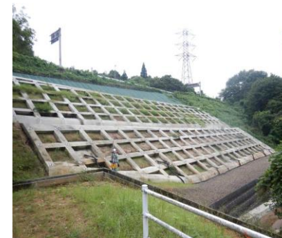
防災対策[法面对策] (国道41号 犬山市善師野)
