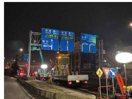
定期点検(門型標識)
