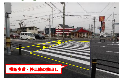
交差点のコンパクト化 国道1号 ぼたる橋南交差（岡崎市）
