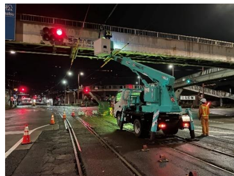
定期点検(横断歩道橋)
