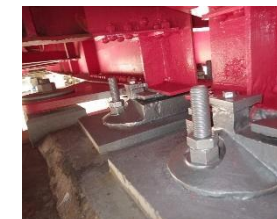
支承防錆処理
