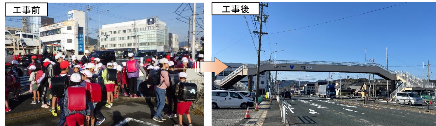
国道1号 国府駅前交差点歩道橋整備（豊川市）
