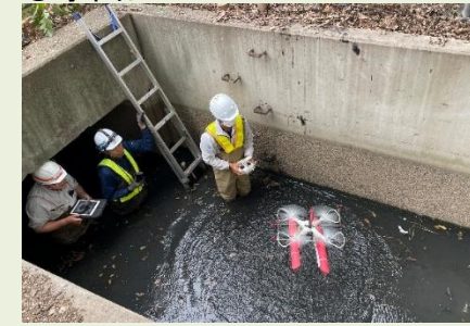
人が入れないような幅が狭く、水深が深い水路での点検
