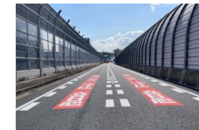
追突への注意喚起・減速ドットライン 国道302号 黒沢台四丁目交差点付近（名古屋市緑区）
