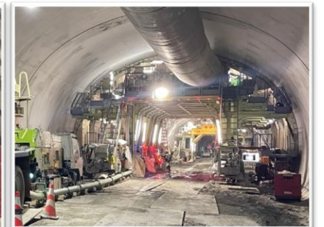
■トンネル覆工の状況
