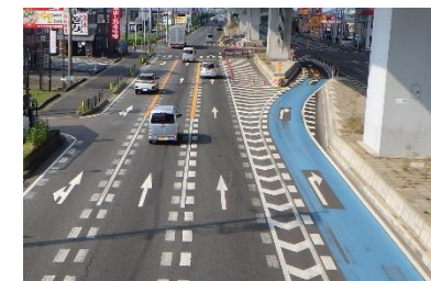
右折車線のセパレート化 国道41号 下小針中島2丁目交差点（小牧市）
