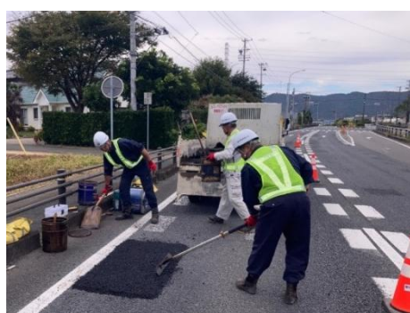
応急対応(路面補修)
