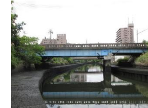
新熱田橋 (1951年架設)
