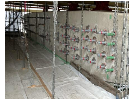
震災対策[橋脚補強] (国道23号 豊川橋)
