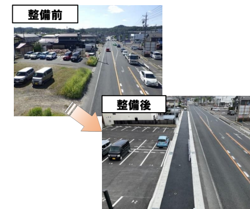
国道155号 山口地区歩道整備
