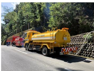
令和4年度 静岡県（給水作業支援）
