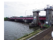
日光川大橋 （1961年架設）
