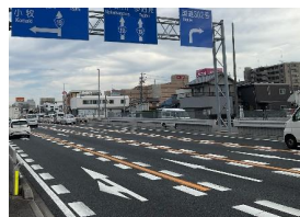
減速ドットライン 国道153号 北山台五丁目交差点
