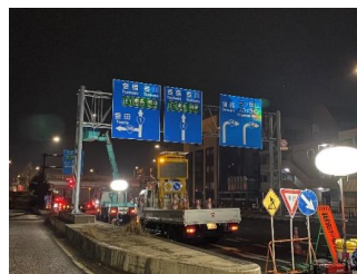
定期点検（門型標識）
