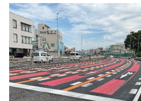
カラー舗装 国道19号 若草通1丁目交差点
