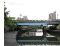
新熱田橋 （1951年架設）
