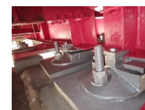
支承防錆処理
