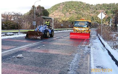
除雪後の道路状況
