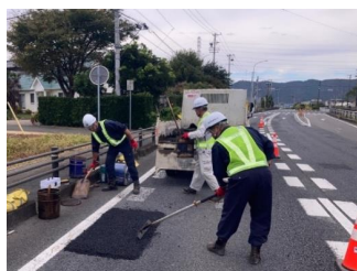
応急対応(路面補修)
