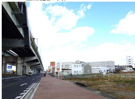
電線共同溝整備後
