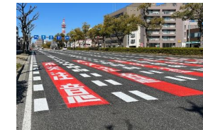
追突への注意喚起 国道19号 西高蔵交差点
