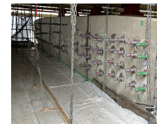
震災対策〔橋脚補強〕 （国道23号 豊川橋）
