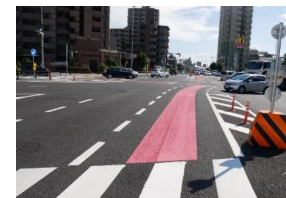
カラー舗装（交差点内） 国道153号 植田一本松交差点
