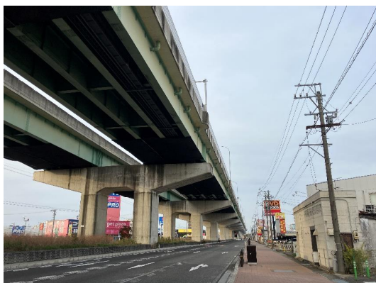
電線共同溝整備前
