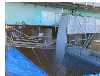
震災対策〔橋脚補強〕 （国道302号 地蔵川高架橋）
