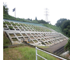
防災対策〔法面対策〕 （国道41号 犬山市善師野）
