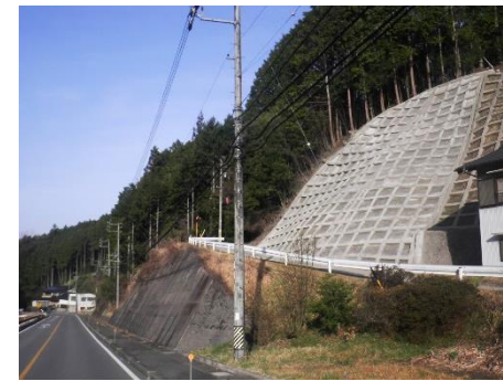
防災対策[法面対策] （国道153号 豊田市北小田）
