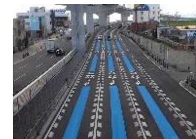
カラー舗装 (右折レーン) 国道22号 堀越交差点
