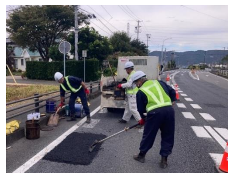
応急対応(路面補修)
