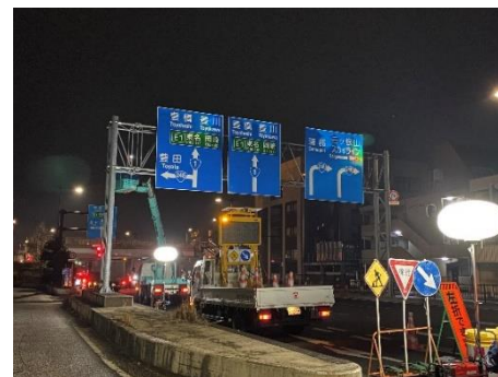
定期点検(門型標識)
