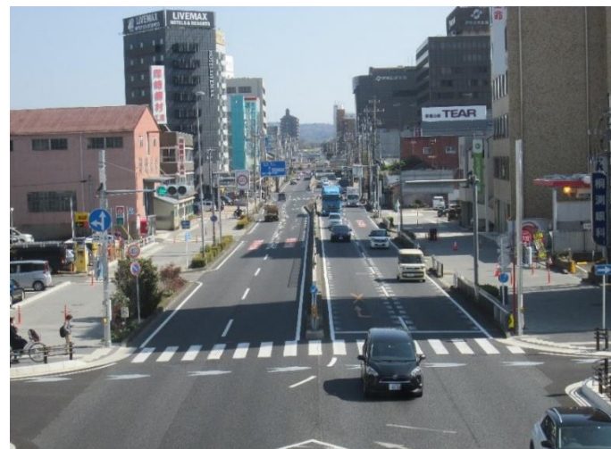
電線共同溝整備後
