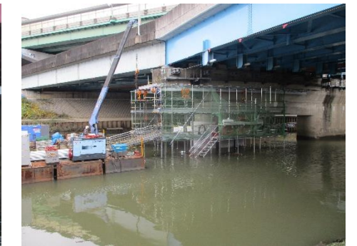
震災対策[橋脚補強] （国道302号 新平田橋）
