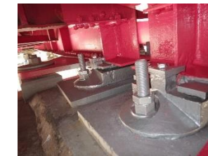
支承防錆処理
