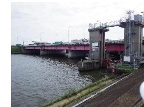
日光川大橋 (1961年架設)
