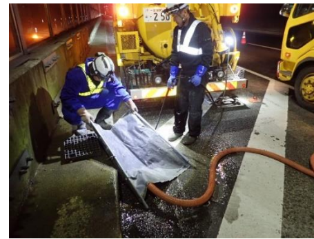
清掃(排水施設)
