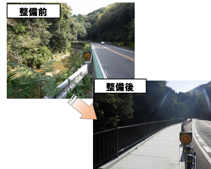
国道153号 勤八地区歩道整備事業
