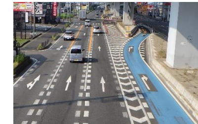
右折車線のセパレート化 国道41号 下小針中島2丁目交差点
