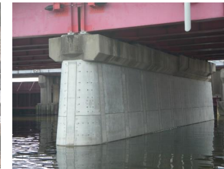
震災対策[橋脚補強] （国道23号 日光川大橋）
