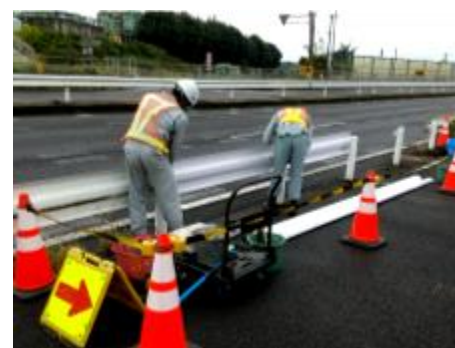
応急対応(付属物補修)
