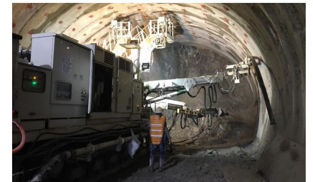
■トンネル掘削の状況
