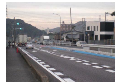
減速ドットライン 国道1号 福祉センター南交差点
