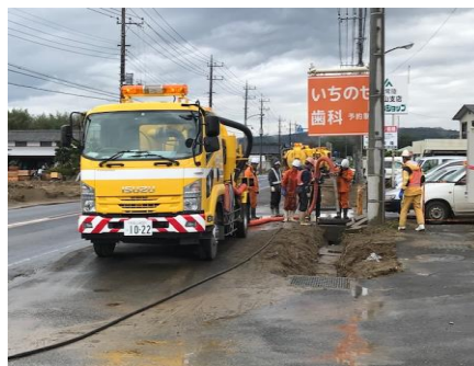
令和元年度 茨城県（路面清掃作業支援）
