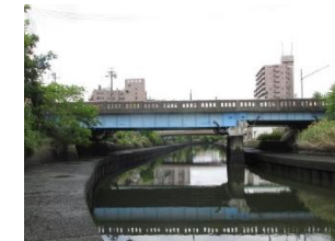
新熱田橋 (1951年架設)
