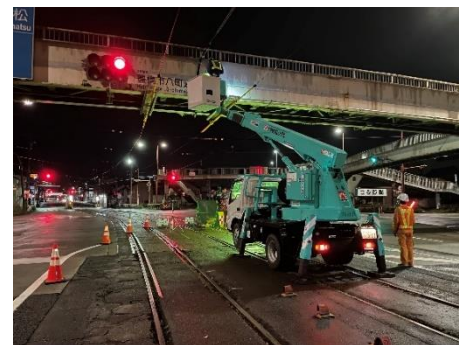
定期点検(横断歩道橋)
