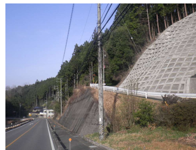
【法面防災対策(法枠工)】
