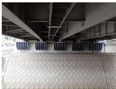
【橋梁耐震補強(水平力分担構造)】
