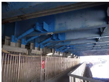
【橋梁耐震補強（上部工）】
