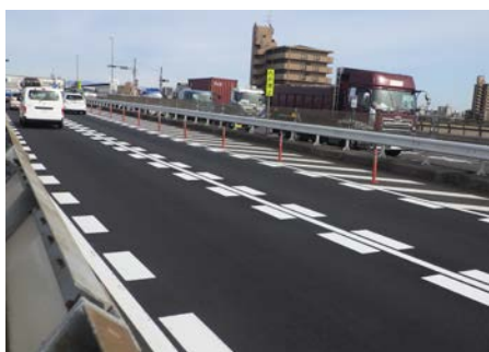
【路面の舗裝修繕】
