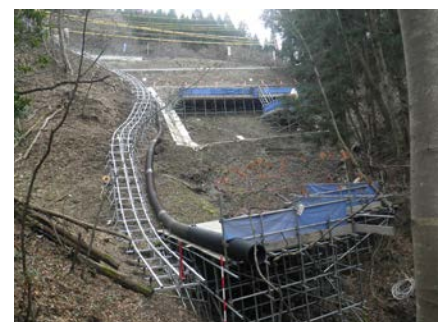
【法面防災対策】
