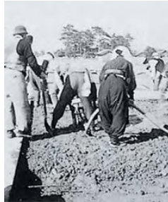
(コンクリート舗装施工状況)
