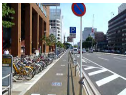
国道 19 号 伏見通自転車走行空間
