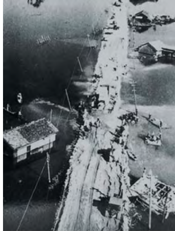
(1959年 国道1号弥富～蟹江間嵩上げ) (伊勢湾台風復旧工事)
