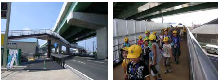
国道 22 号 伝法寺歩道橋
