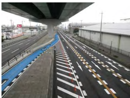
国道 41 号 花塚橋南交差点
