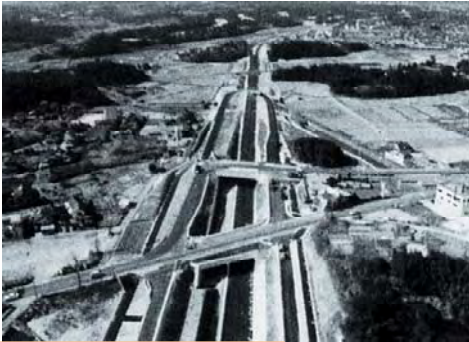
(1980年 国道153号 豊田西バイパス供用開始)
