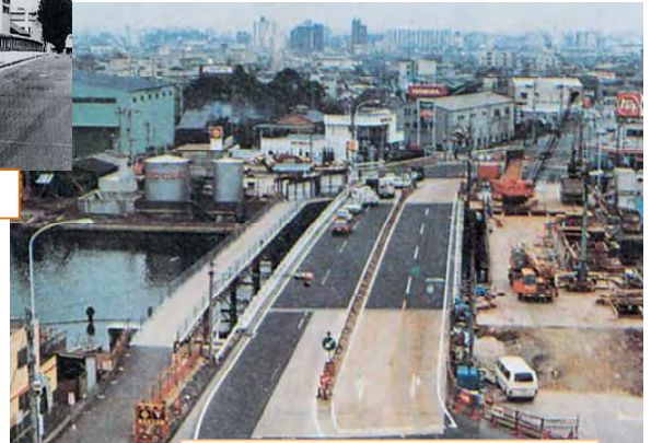
(1981年 国道1号昭和橋架替工事)
