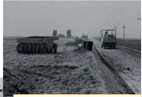
(1962年 国道22号名岐ハイパス改良工事)
