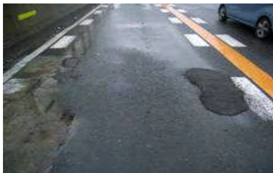
維持的補修の事例(左:穴ぼこの補修 右:部分打ち換え)
