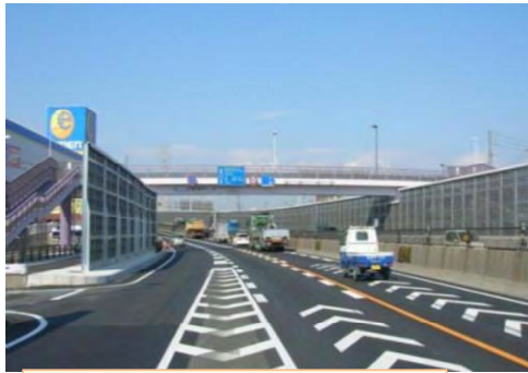
(2007年 国道23号名四横断歩道橋)
