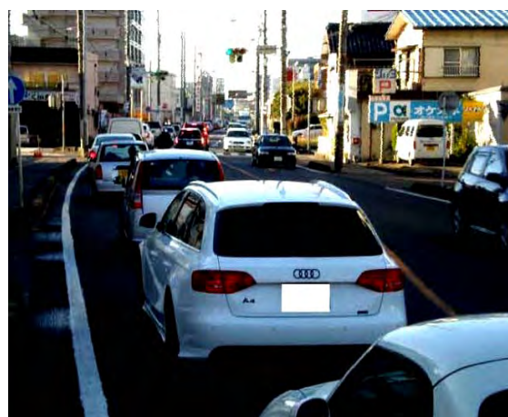
(平成 23 年 153 号陣中交差点改良工事・(現況))
