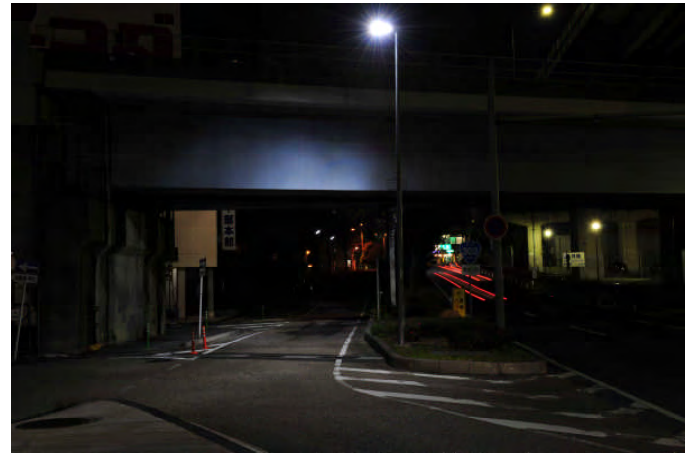
施工後(LEDランプ)
