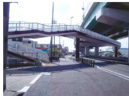
国道 22 号 伝法寺歩道橋
