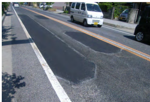
維持的補修の事例(左:穴ぼこの補修 右:部分打ち換え)
