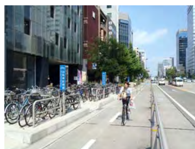
国道 19 号 桜通自転車道
