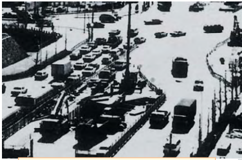
(1979年 国道22号丸の内共同溝着手)
