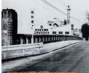
架替前の昭和橋
