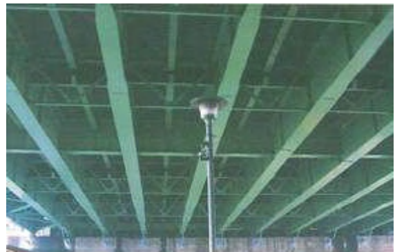
床版補強状況(増桁工法)
