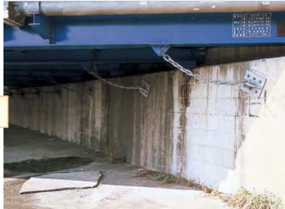
(1976年 震災対策による落橋防止工事着手)
