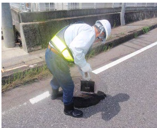
ポットホールの修繕
