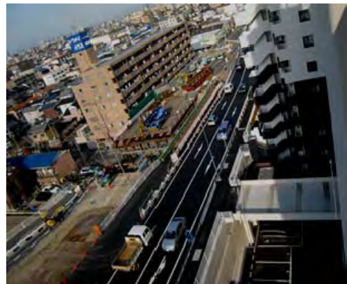
(高杉町～下之一色町間の工事状況)
