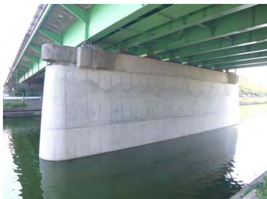
写真 下部工のRC巻立て
