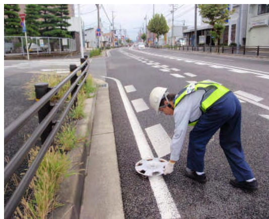
落下物の撤去
