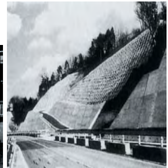
(1986年 国道153号勘八防災工事)
