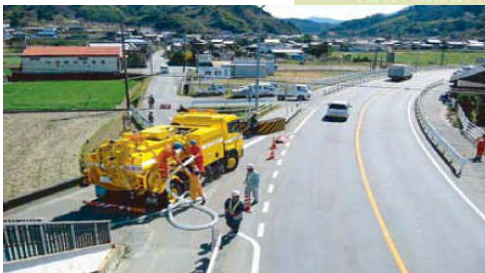
清掃作業状況
