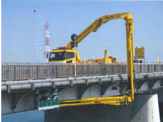
橋梁点検車による点検状況
