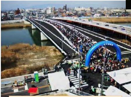
(2010年 国道1号一色大橋渡り初め)
