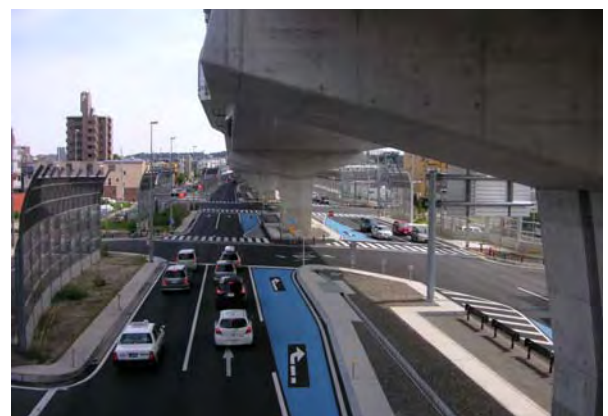
国道 302 号 水主ヶ池交差点より北方を望む
