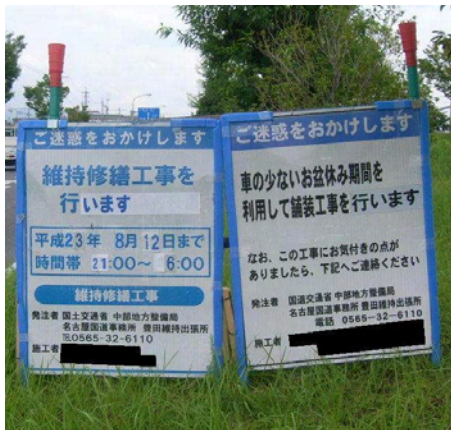
工事看板の設置例
