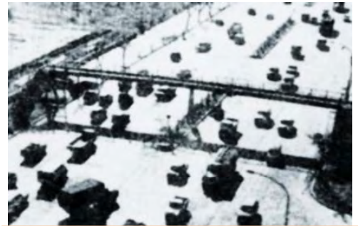
(1965年 横断歩道橋・歩道橋添加・歩道舗装工事着手)(上記写真 名古屋市南伏見通り)
