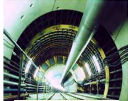
(2009年 国道19号春日井共同溝)
