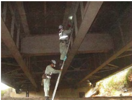
梯子による点検風景
