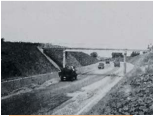
(1955年 国道1号豊明新道改良工事)
