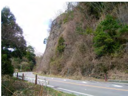
法面防災 対策前
