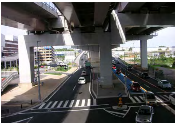
国道 302 号 原一丁目交差点より南方を望む
