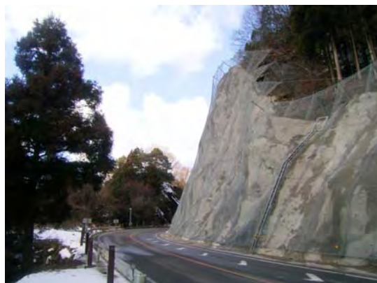
法面防災 対策後
