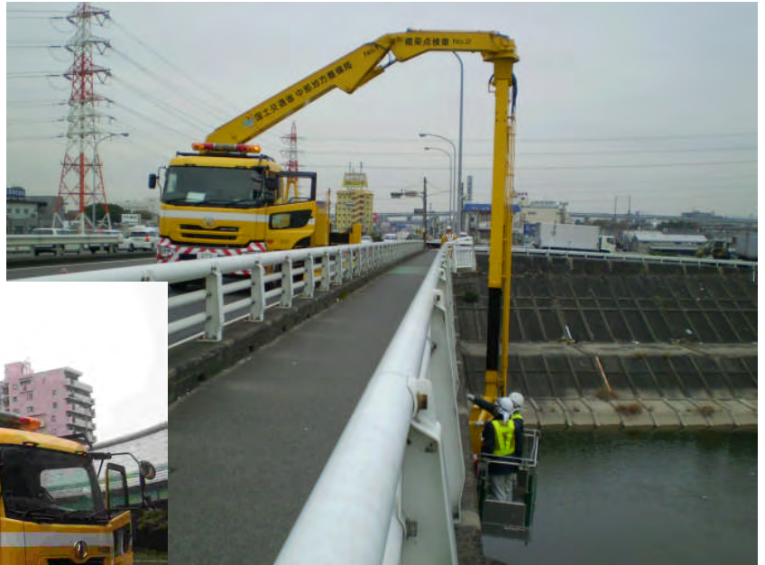
橋梁点検状況(作業員の目視により損傷状況確認)
