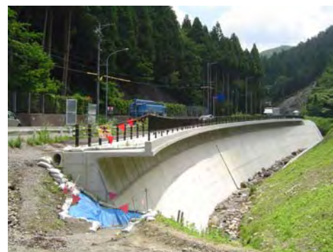
国道 153 号 明川地区避讓車線設置工事
