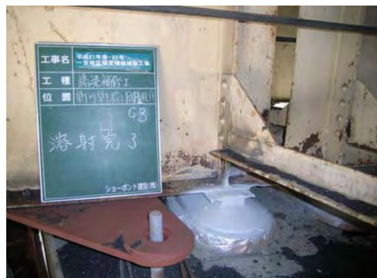
写真 支承の防錆措置
