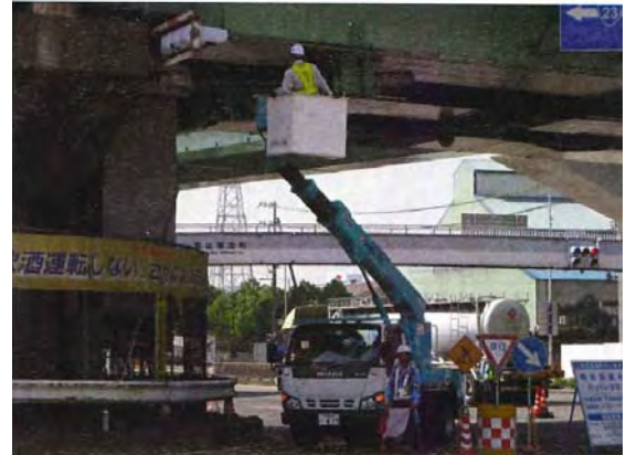
リフト車による点検状況
