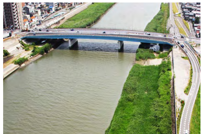
(平成22年 架替工事が終了した一色大橋)
