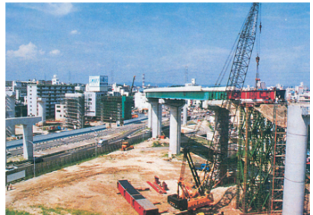
(平成 3 年 上社ジャンクション付近の工事風景)
