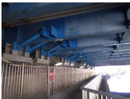
【橋梁耐震補強（上部工）】
