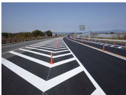
【路面の舗裝修繕】
