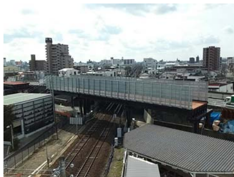
【迂回路橋施工状況】
