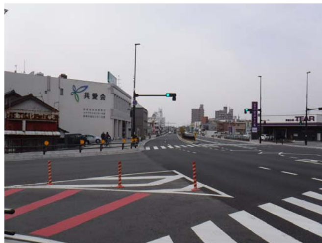
国道1号一色(I)電線共同溝（整備後）
