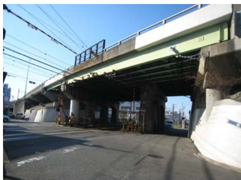
【国道1号熱田伝馬橋（現況）】
