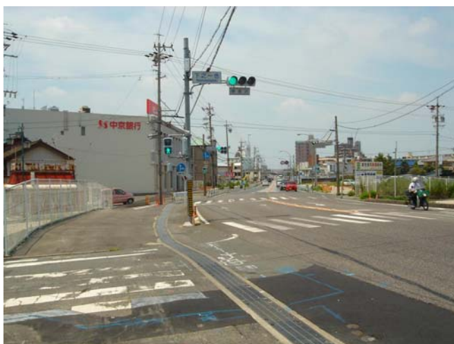
国道1号一色(I)電線共同溝（整備前）
