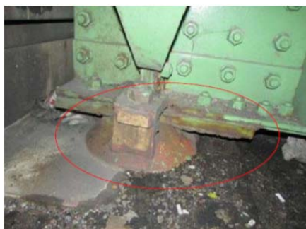
【橋梁支承部の腐食】
