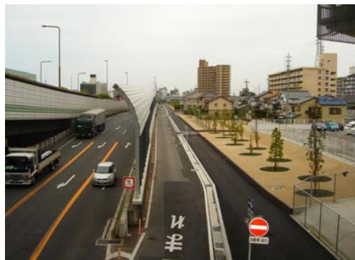
国道 23 号 モデル地区 環境施設帯整備
