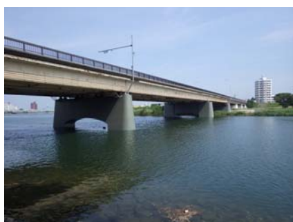
【橋梁耐震補強（下部工）】
