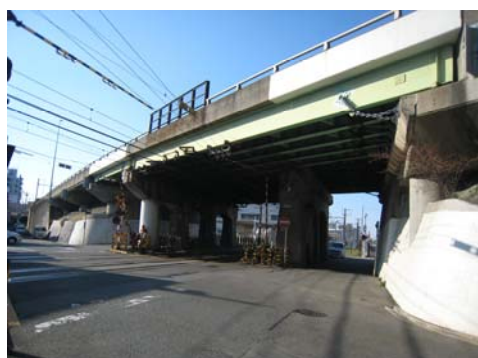
【国道1号熱田伝馬橋（現況）】
