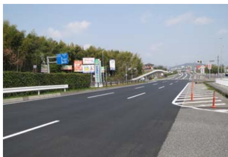
【路面の舗裝修繕】
