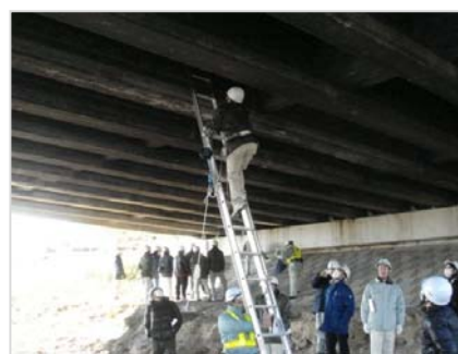
【橋梁点検講習会】
