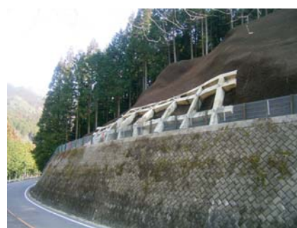
【法面防災対策】
