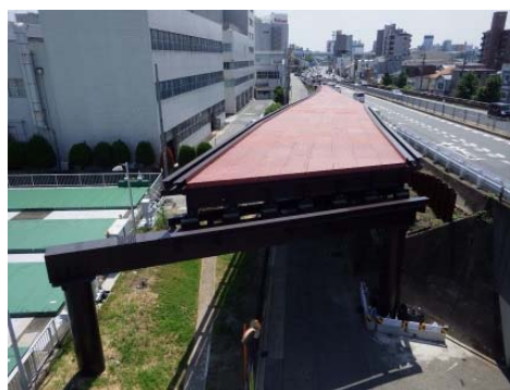
【迂回路橋施工中状況】
