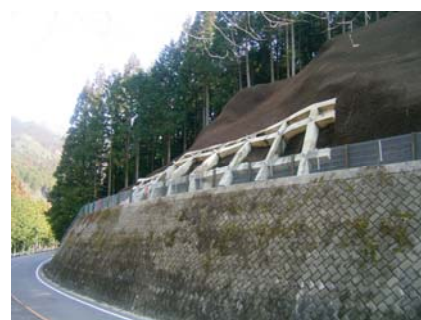
【法面防災対策】
