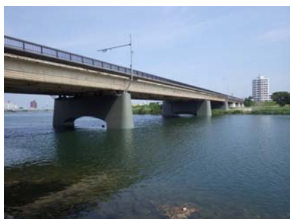
【橋梁耐震補強（下部工）】
