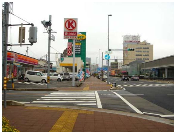
国道22号枇杷島電線共同溝（整備後）
