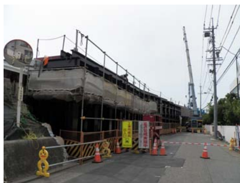
【仮橋施行中状況】
