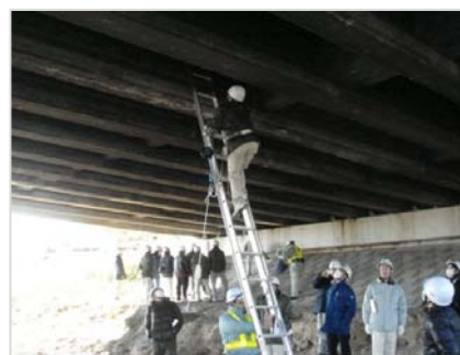
【橋梁点検講習会】
