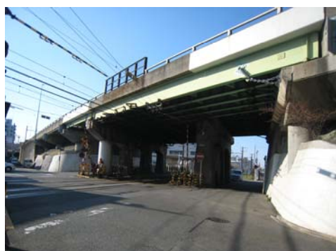
【国道1号熱田伝馬橋（現況）】
