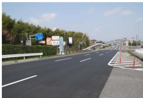
【路面の舗裝修繕】
