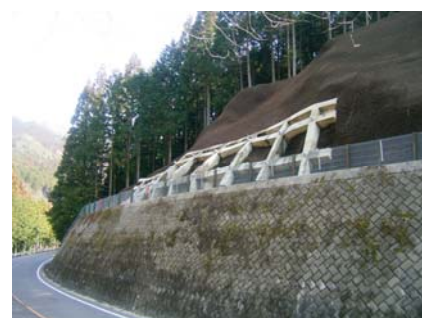
【法面防災対策】
