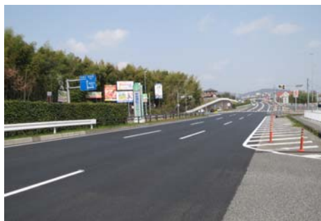
【路面の舗裝修繕】
