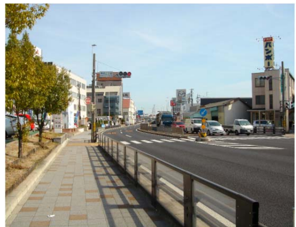
星崎電線共同溝（整備後）
