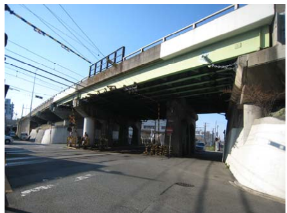
国道1号熱田伝馬橋（現況）
