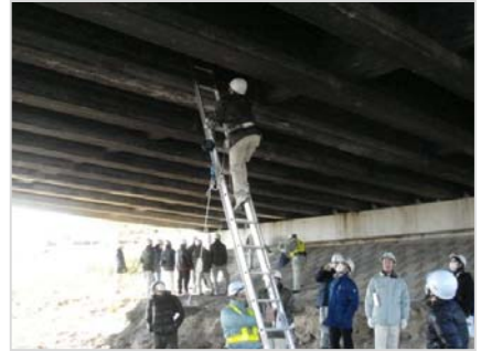
【橋梁点検講習会】
