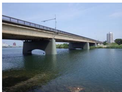
【橋梁耐震補強（下部工）】
