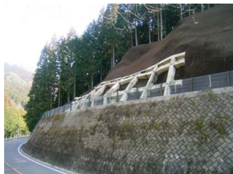
【法面防災対策】
