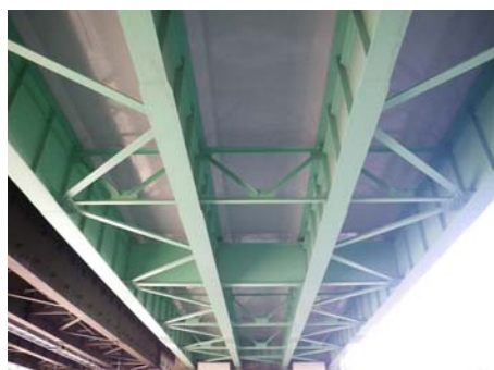
【床版補修（剥落防止）】
