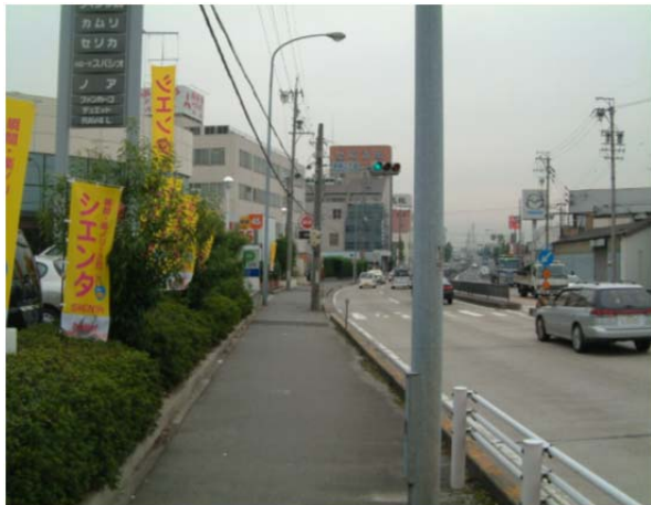
星崎電線共同溝（整備前）
