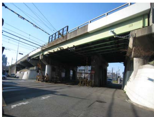
国道1号熱田伝馬橋（現況）
