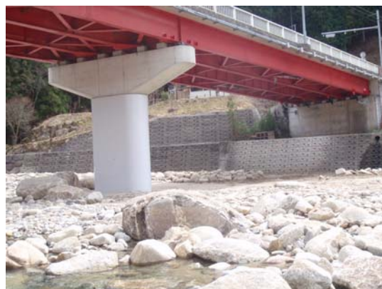
【橋梁下部工補強】
